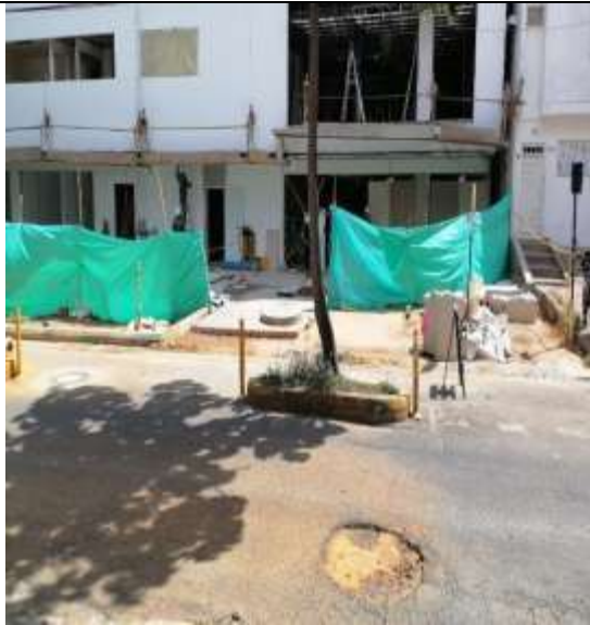
Imagen 4. Se observa segundo pozo en la franja ambiental.
