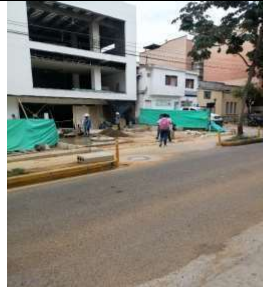
Imagen 3: Se observa instalacion de pozo en el separador de la cicloruta.
