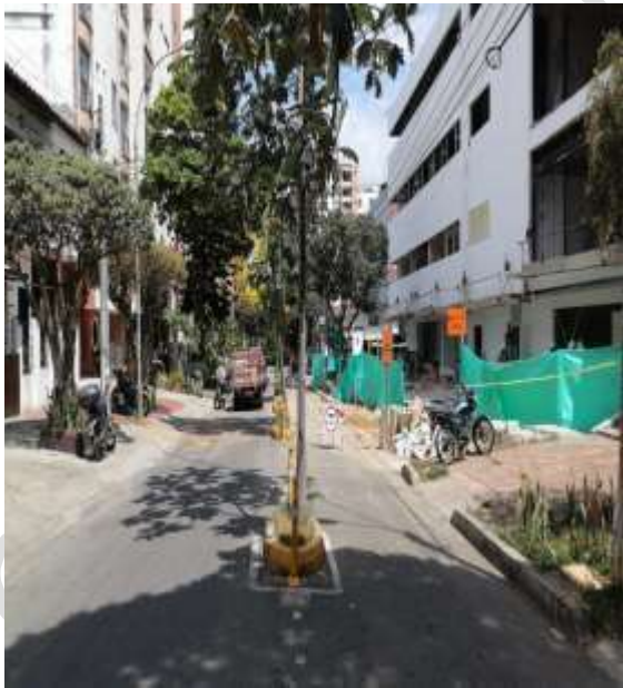
Imagen 1: se observa obra en la carrera 30 con calle 33.
