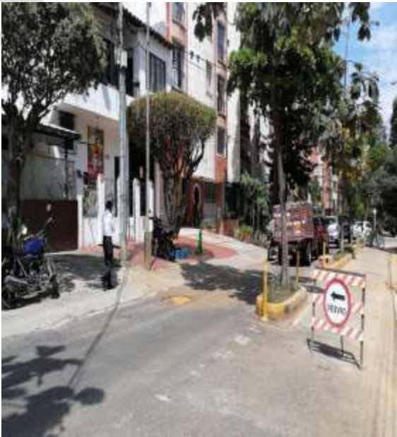
Imagen 2. En el momento de la visita estaban realizando intervenciones en la calzada de cicloruta.
