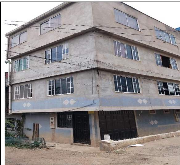
Imagen 1: Frente del predio Barrio: Brisas de paraíso
