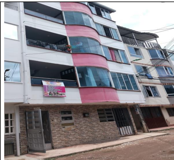
Imagen 1: Frente del predio Barrio: Brisas de paraíso
