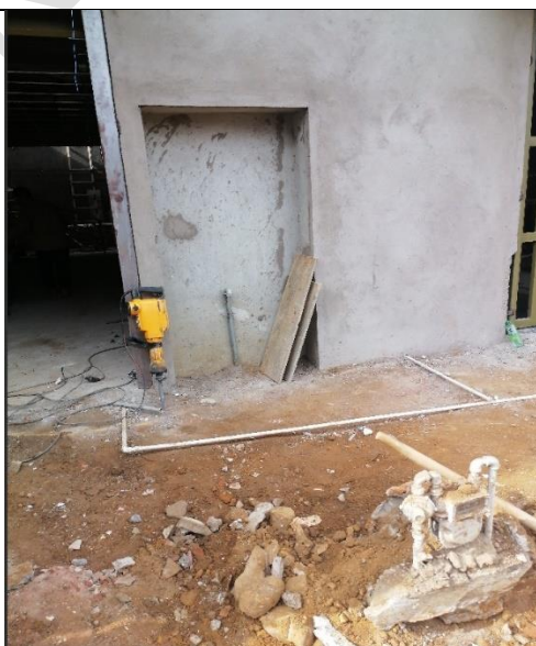
Imagen 4: Sitio para instalación de medidores en el paramento del Edificio.
