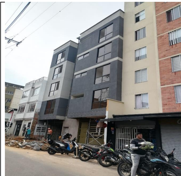
Imagen 1: Calle 42 No 8- 58 Edificio de 5 pisos
