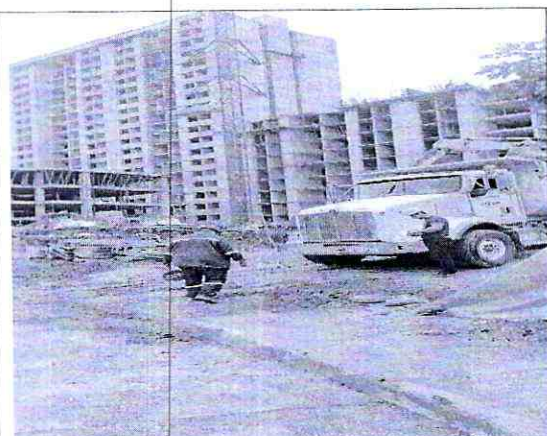
Imagen 3: Perfil del predio – Calle 102. Barrio Fontana
