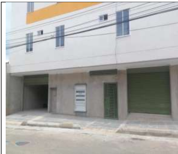
Imagen 1: Fachada del predio Barrio La Joya.
