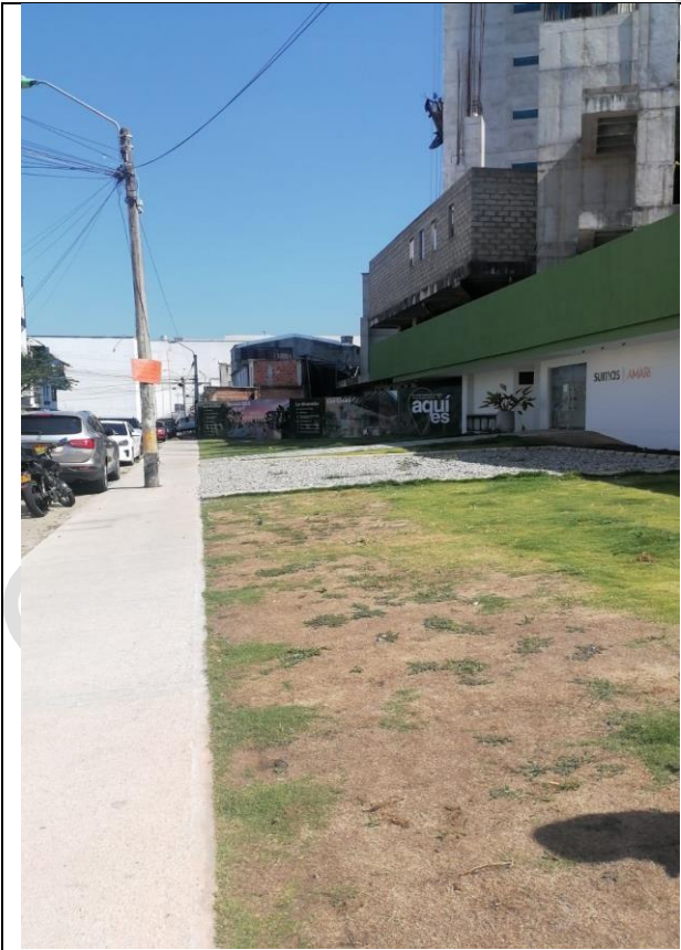
Imagen 1: Rotura del antejardín, e instalación de cajas de MT sobre la carrera 34 Barrio: Galán.
