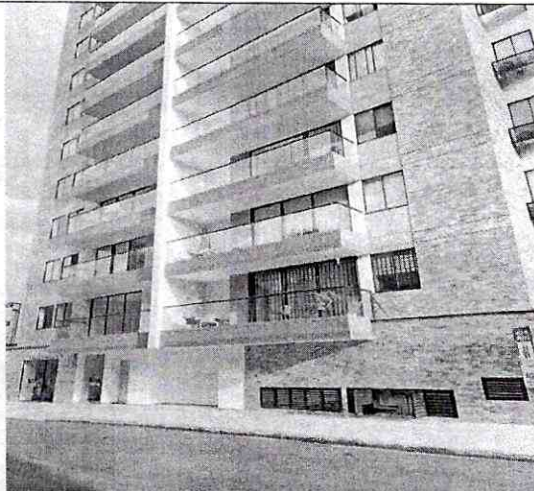
Imagen 1: Frente del predio Calle 66 # 33 – 166 Barrio: Las Flora
