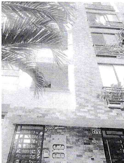
Imagen 3: El Edificio García, está compuesto por 5 pisos como lo indica los planos aprobados por la Curaduría.
