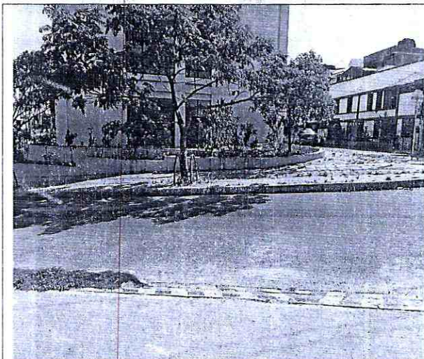
Imagen 1: Prolongue de la red, en la calle 28 con carrera 30 y cruce de la vía por topo misil. Barrio Mejoras Publicas.
