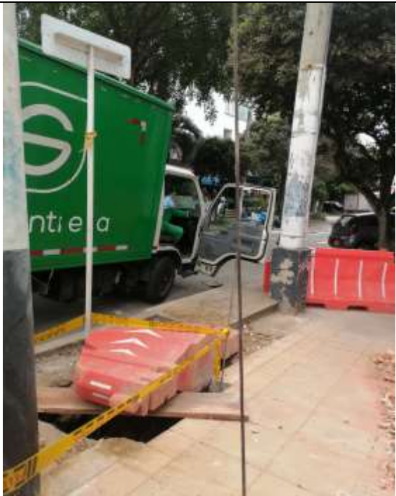
Imagen 5: Perfil en la Franja de circulación sobre la calle 32.
