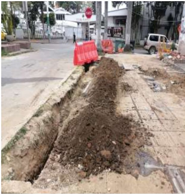
Imagen 4: Se observa canalización en la franja de circulación.
