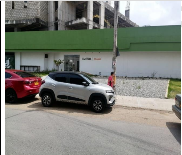
Imagen 1: Rotura del antejardín, Franja ambiental para conexión de red e instalación de Hidrante sobre la carrera 34. Barrio: Galán.
