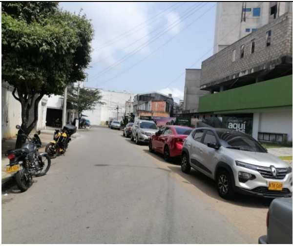
Imagen 2: Rotura en la calzada sobre la carrera 34. Barrio: Galán
