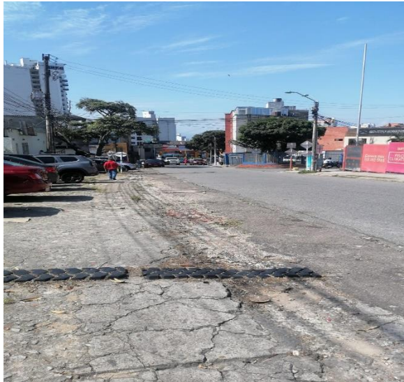
Imagen 4: se va a realizar rotura en la calzada para conectarse a la red del agua.
