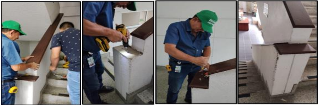
Imagen: Arreglo de los pasamanos
