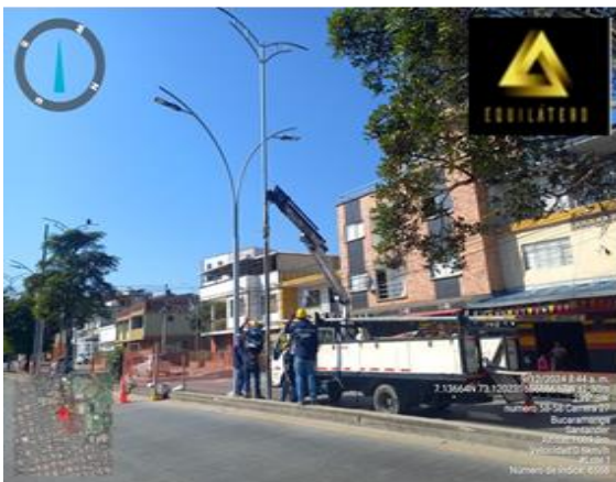
Imagen 1. Instalación de postes
