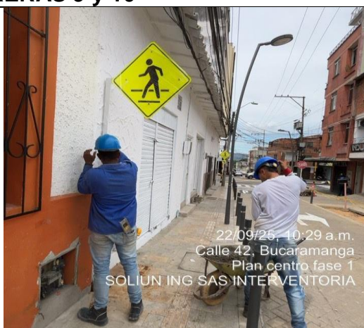
Instalación de señalización vertical
