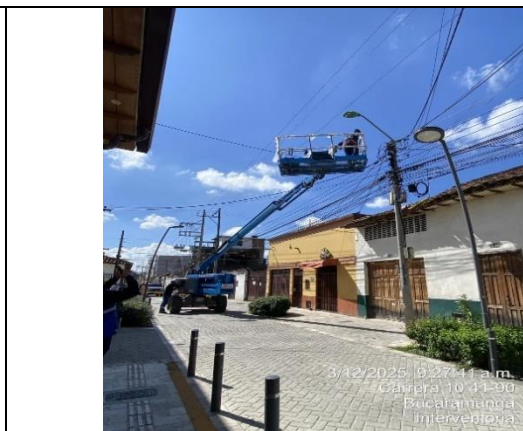
Desmonte de luminarias existentes para entrega a la entidad sobre la carrera 10
