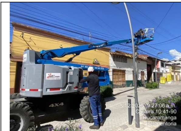
Desmonte de luminarias existentes para entrega a la entidad sobre la carrera 10
