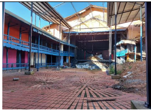
Estado Interior de la edificación.
