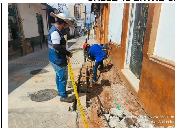
Excavación para replanteo área de andén
