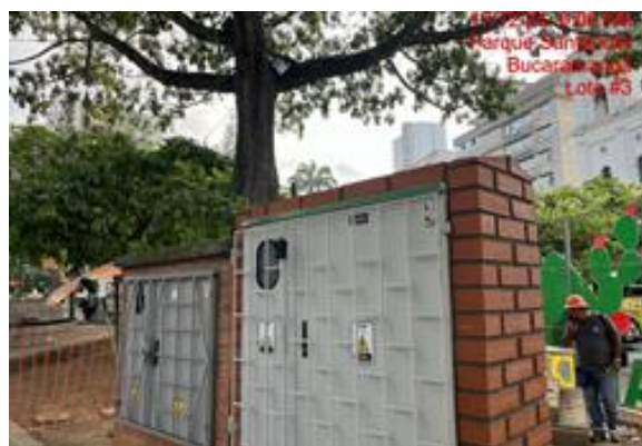
Imagen 2. Construcción de tablero
