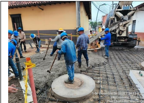
Fundida en concreto MR42 calzada vial
