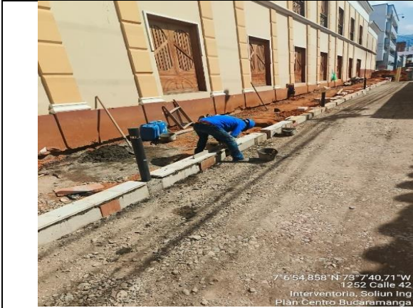
Instalación de enchape en sinu veta sobre sardinel costado norte
