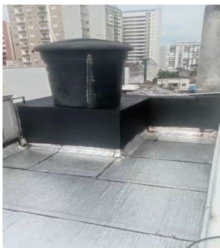
IMAGEN No 1: IMPERMEABILIZACION PLACA DE CUBIERTA
