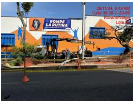
Imagen 1. Instalación de postes
