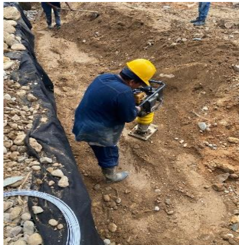
Imagen No 2: excavaciones en roca a maquina. Imagen No 3. Compactacion rellenos
