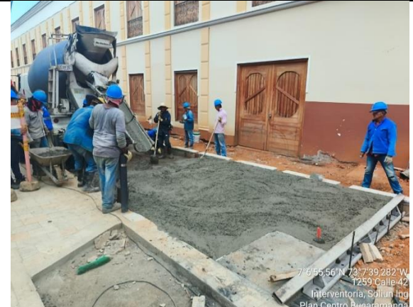
Fundida de losas en concreto MR42
