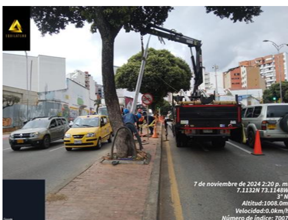
Imagen 1. Instalación de postes
