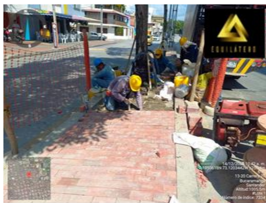
Imagen 2. Instalación de adoquín
