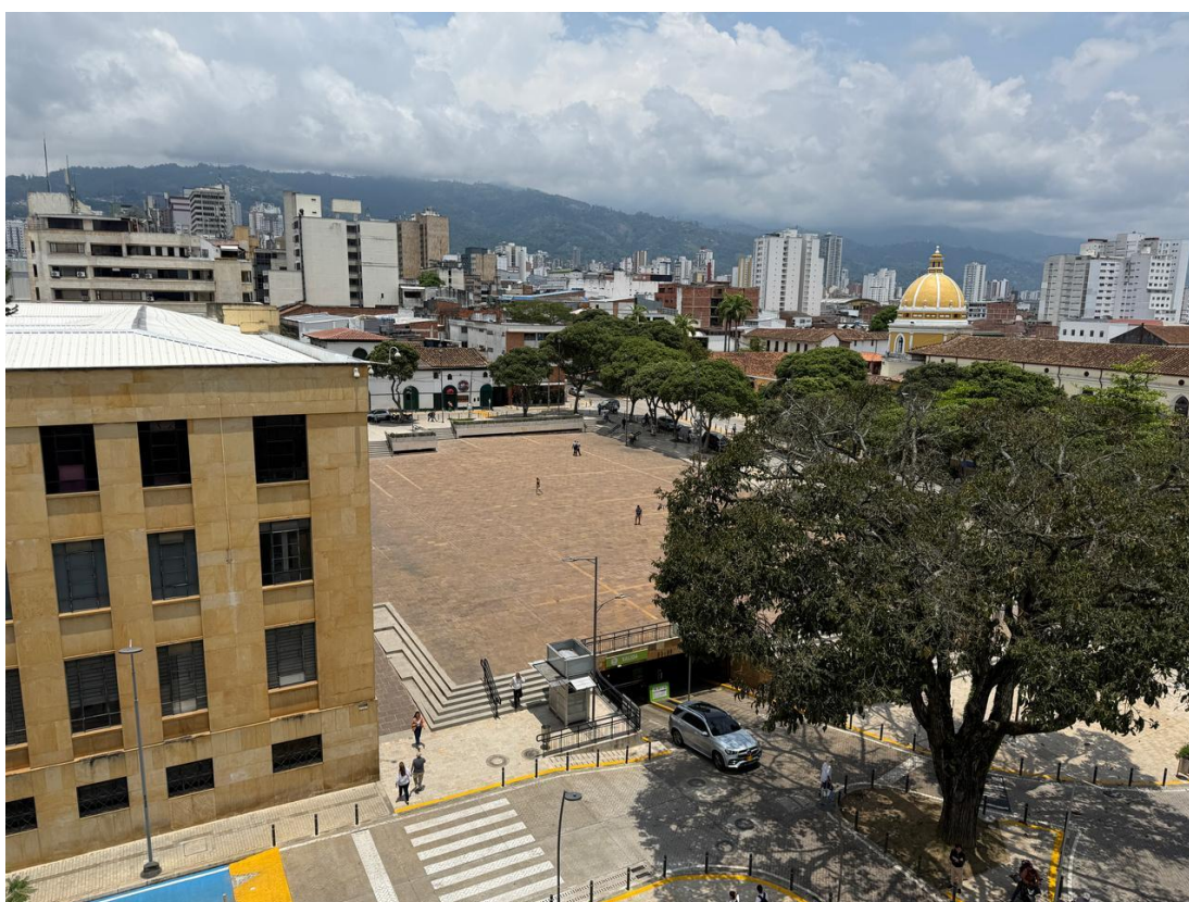
Estado final de la Plazoleta Luis Carlos Galán
