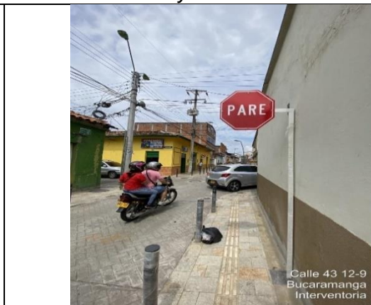
Instalación de señales de tránsito verticales
