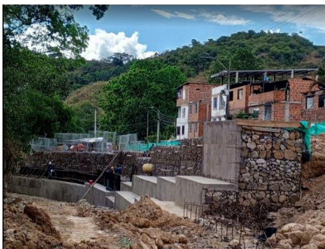
Imagen No 6: armado de gaviones.
