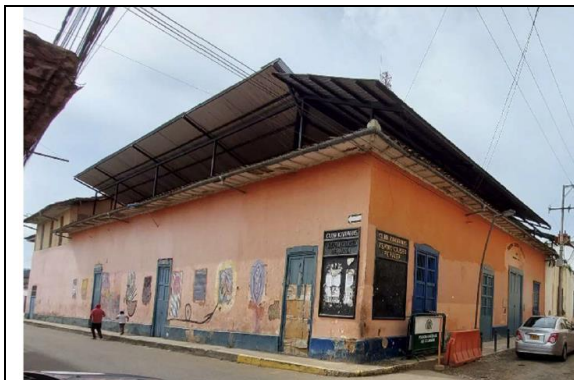
Estado Fachada Actual
