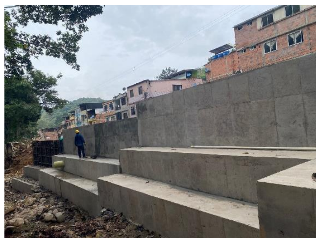
Imagen No 7: recubrimiento de gaviones en concreto.
