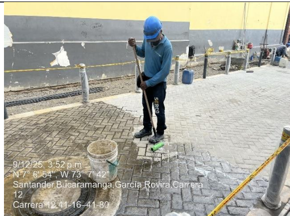
Sellado de losas con sellante epoxico
