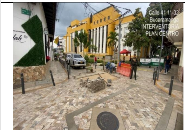
Mantenimiento de adoquín vehicular en travertino calle 41 con cra 11
