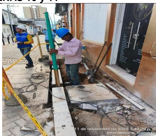
Excavación para bolardos esquina con cra 11
