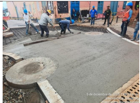
Fundida en concreto MR42 calzada vial
