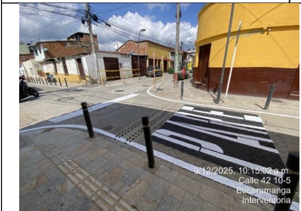
Señalización horizontal intersecciones cra 10 con 41 y cra 10 con 42
