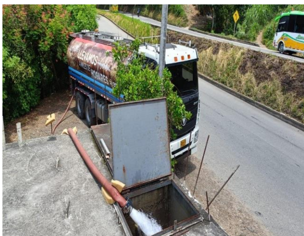
Imagen No 1. Suministro de agua potable Villa Carmelo
