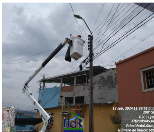
Imagen N°2 Reemplazo de luminaria
