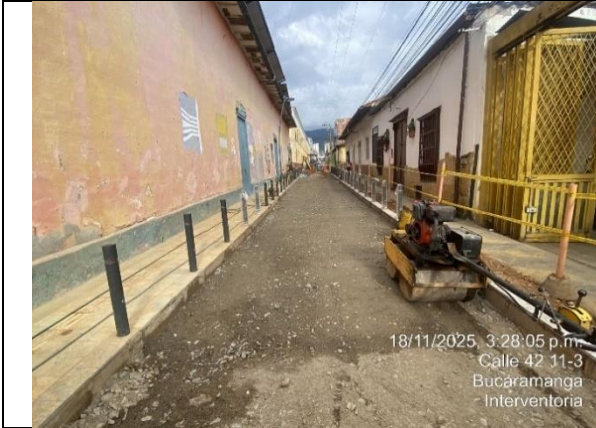
Compactación de capa de base granular sobre calzada vehicular
