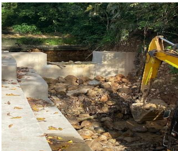
Imagen No 2: excavaciones en roca a maquina. Imagen No 3. Compactacion rellenos
