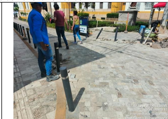
Mantenimiento de adoquín vehicular en travertino calle 41 con cra 11
