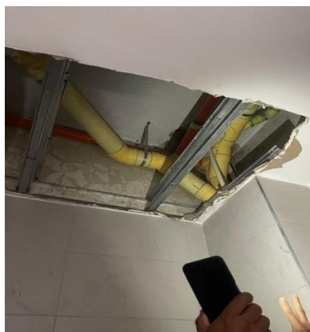
IMAGEN No 2: DEMOLICION CIELO RASO Y REVISION FILTRACIONES
