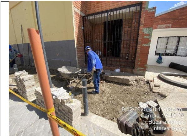
Compactación subase granular en sendero peatonal costado oriental
