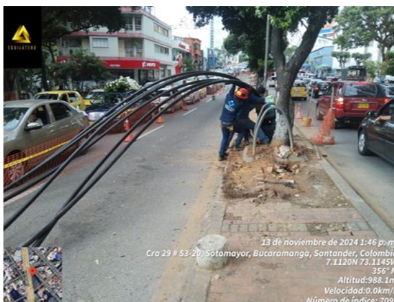
Imagen 2. Tendido de redes
