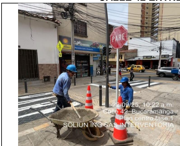
Instalación de señalización vertical
