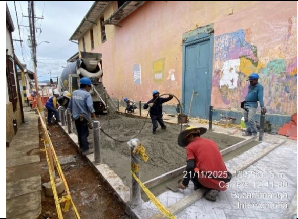
Fundida de concreto losas de pavimento MR42
