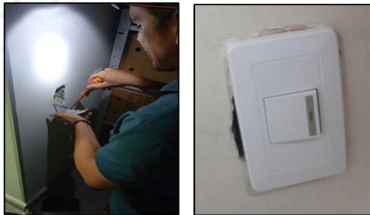
Imagen: Cambio apagador de luz Archivo Central Sotano Fase I
