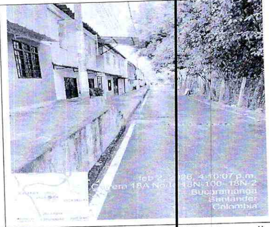
Imagen 12: Carrera 18AN entre calles 18 y 19, vía protección
