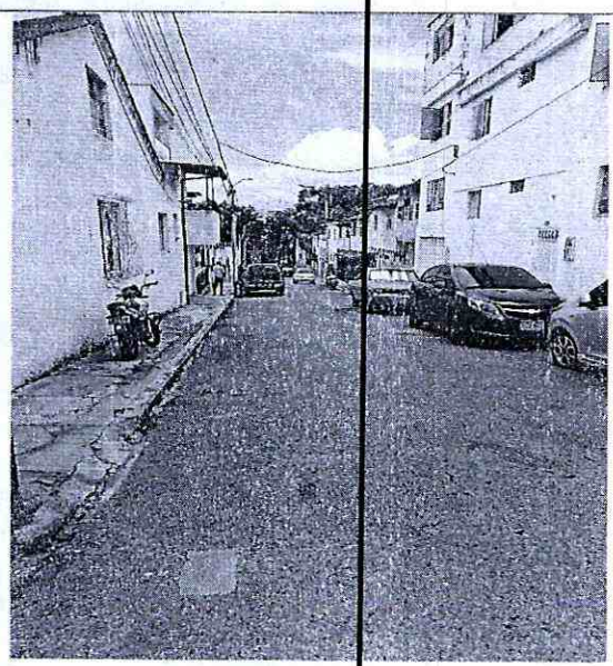
Imagen 6. Calzada en condiciones regulares.
