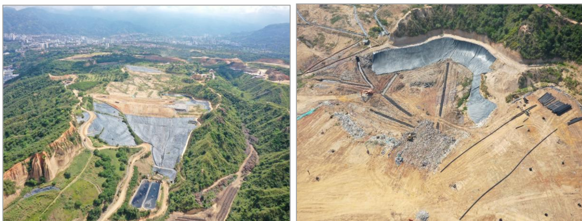
Imagen. Imagen construcción de celdas etapa 1
