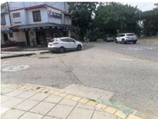
Transversal Metropolitana entre calle 64Cy la calle 65
