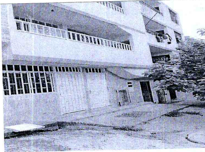
Imagen 3: caja de contadores de gas- carrera 24
