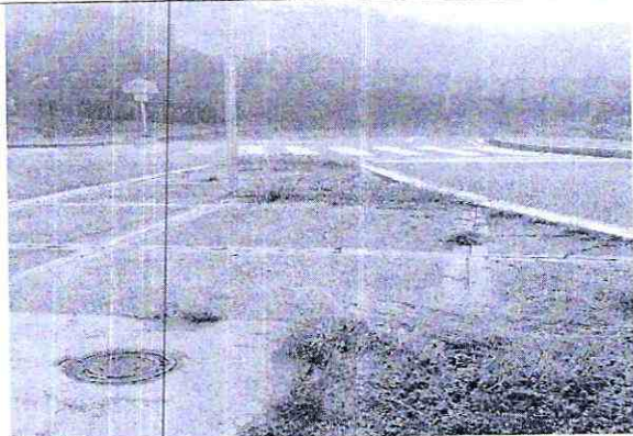
Imagen 3: Cruce de la calzada 66
