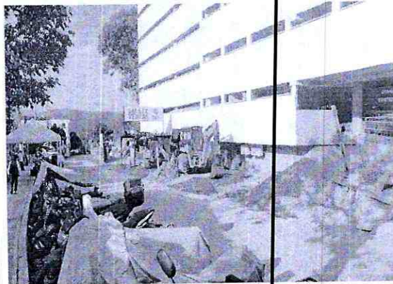
Imagen 6: Espacio publico por donde se construye la red
