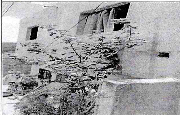
Imagen 9: MZ C/ 16/ Calle 34N #23- -21 construidos 2
