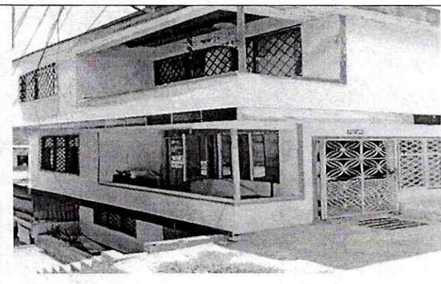
Imagen 12: MZ D/ 26/ Calle 35N #23- 21- construidos 3 pisos
