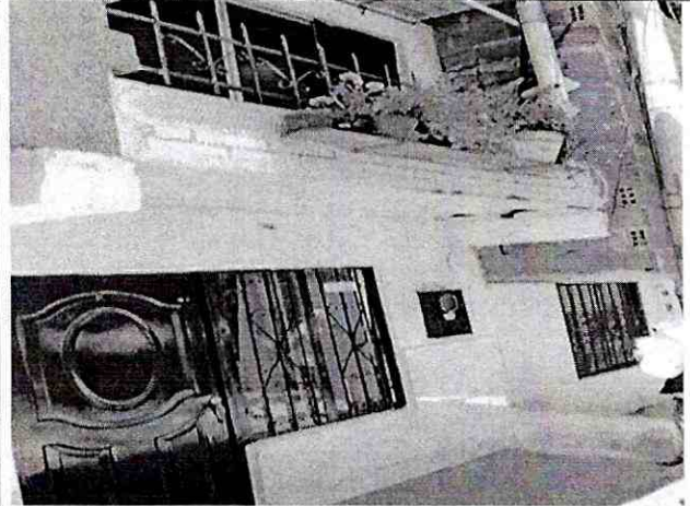
Imagen 78: MZ M/ 74 Transversal 36N # 24-10 Piso 1
