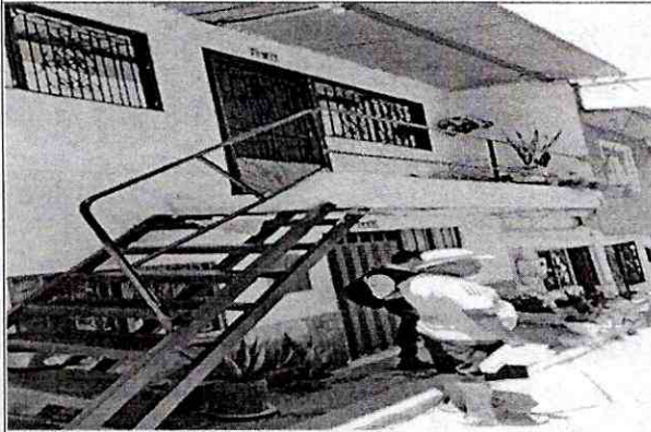
Imagen 79: MZ M/75 Transversal 36N # 24 -04 piso 1
