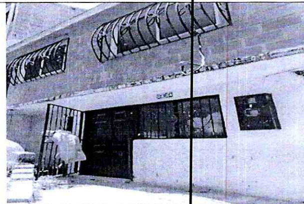
Imagen 76: MZ M/70 Transversal 36N # 24-24 Piso 1
