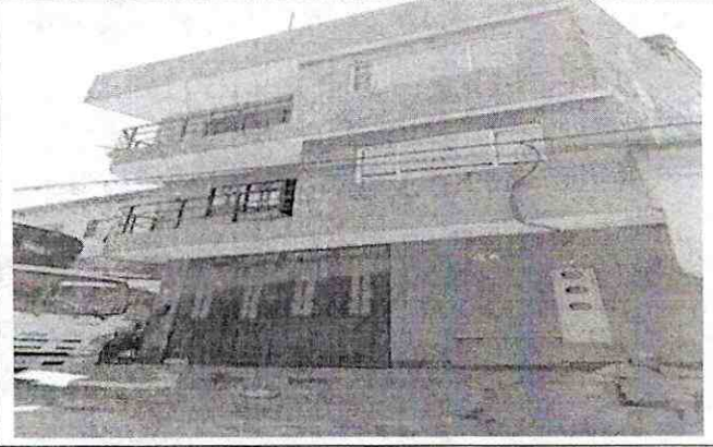
Imagen 54: MZ J/ 56 Calle37N# 25-10 Piso 1 / 4P. Piso 1
