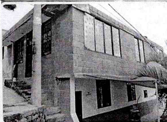
Imagen 69: MZ-L/77 Avenida 34N # 36-20 piso 1
