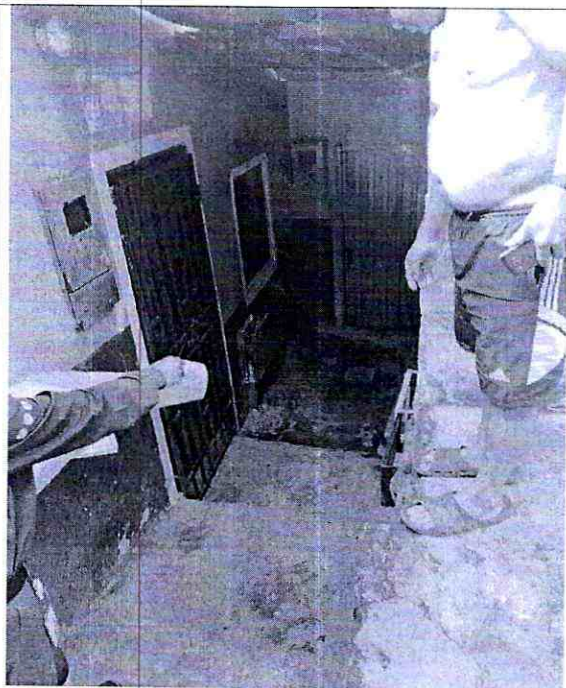
Imagen 3: Apique 3 en la calle 59N No 9-18 Barrio EL PABLON
