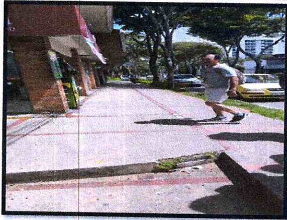
Imagen 3: Av. González Valencia entre las Calles 55 y 55ª (Costado Occidental).
