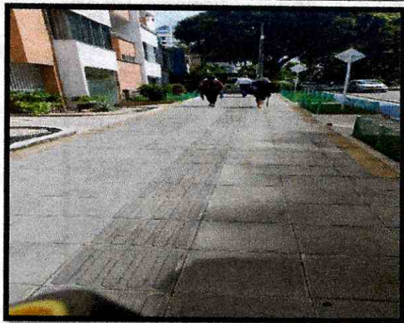
Imagen 11: Carrera 35 entre las Calles 41 y 42 (Costado Occidental).
