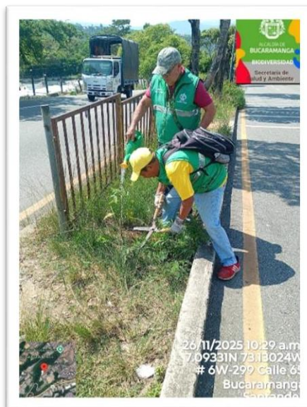
Fotografía No. 24. Mantenimiento separador Vial Rionegro.
