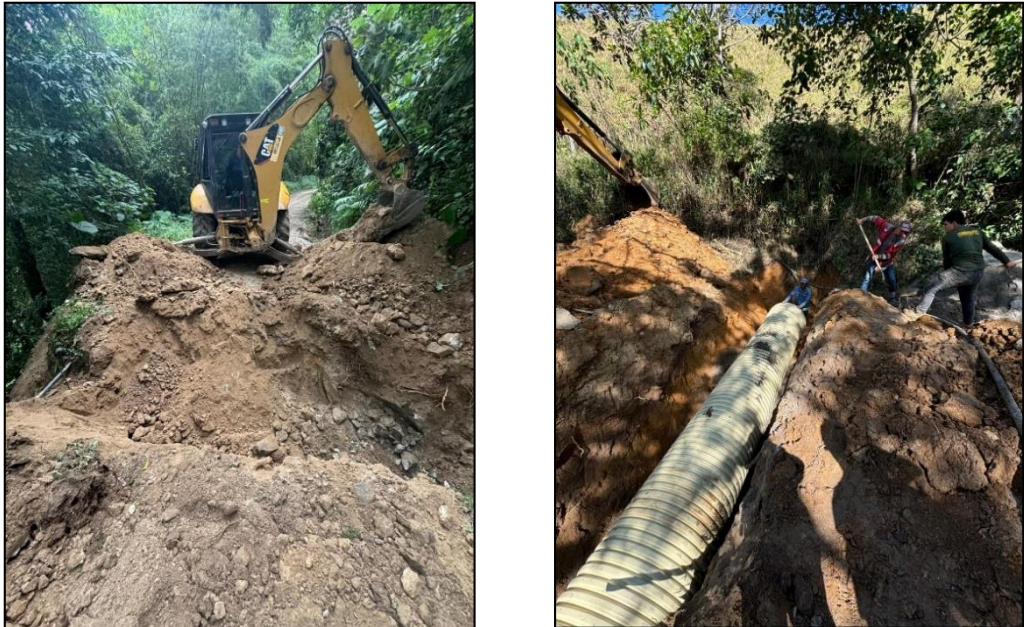
Obras de drenaje en la Vereda Santa Rita
