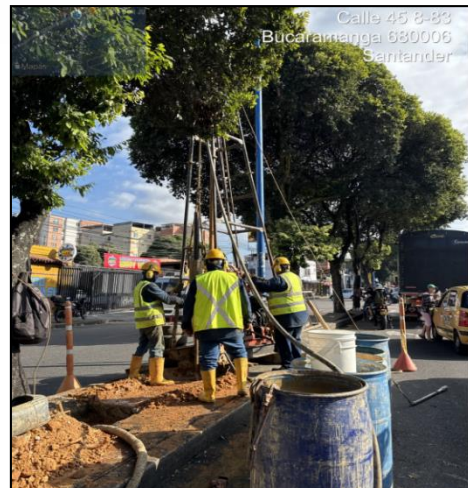
Figura 2 Exploración geotécnica Directa
