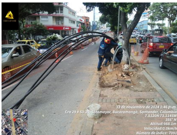
Imagen 2. Tendido de redes
