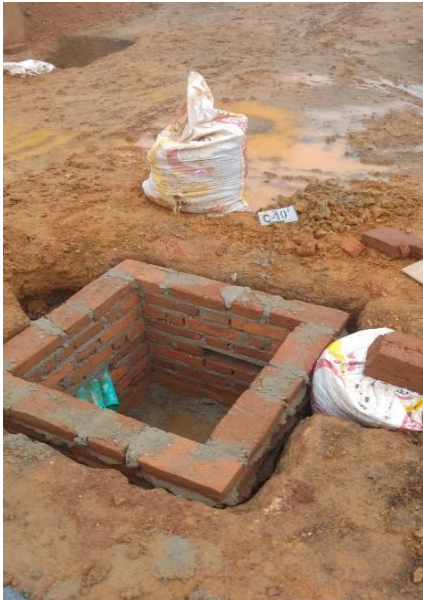
Redes de alumbrado público ducteria y cajas de inspección
