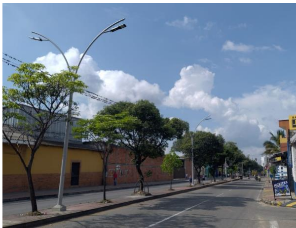
Imagen No.1. Instalación de postes y luminarias
