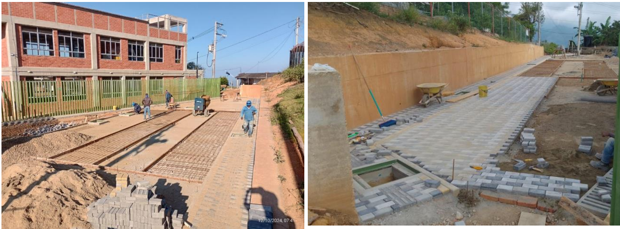
Área la cancha- muro –cerramiento costado norte
