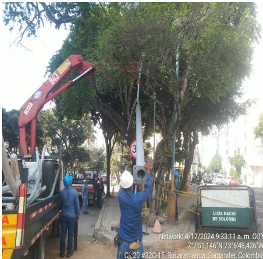
Imagen No.2. Instalación de postería nueva
