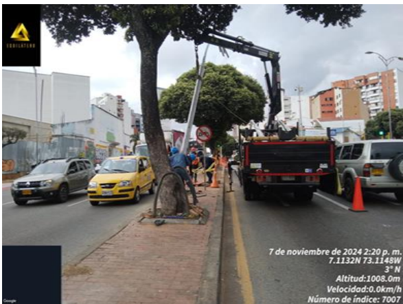
Imagen 1. Instalación de postes
