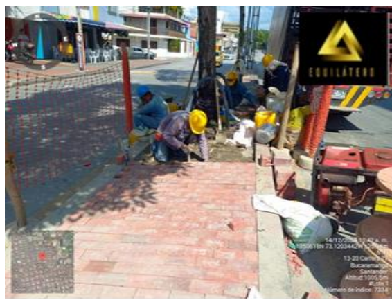
Imagen 2. Instalación de adoquín
