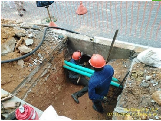
Imagen No. 2 Excavaciones topomisil
