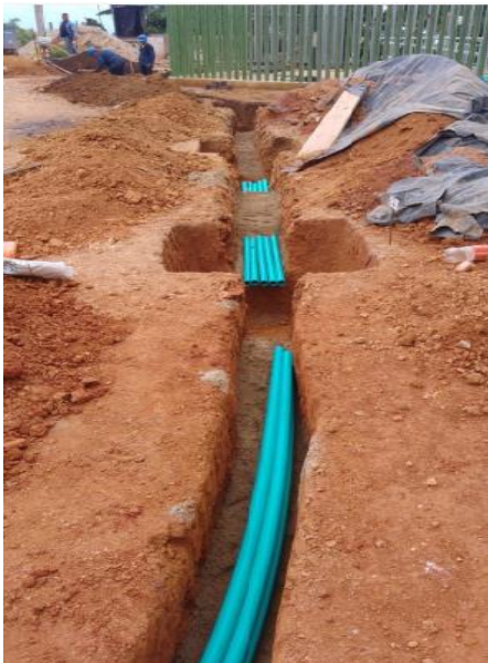
Redes de alumbrado público ducteria y cajas de inspección
