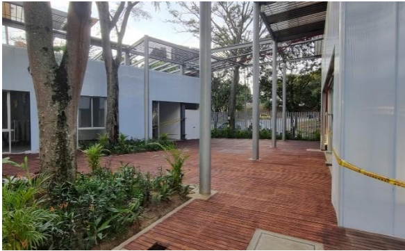
ACTUAL: Módulos B y C, Fachadas principales, área zona común.
