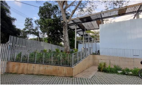
ACTUAL: Modulo A, Fachada principal zona de parqueadero.
