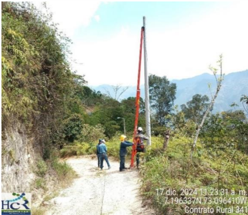
Imagen No 1. Tendido de Red aerea y conexión de elementos de soporte y fijación
