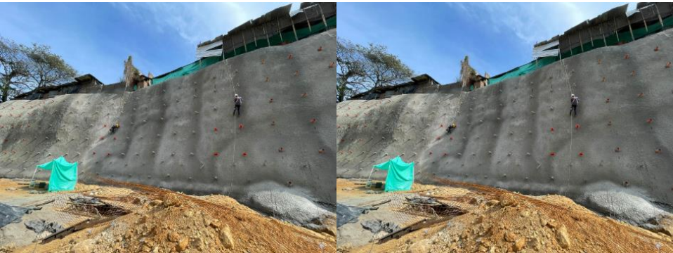
Imagen: Obra Gaitán
