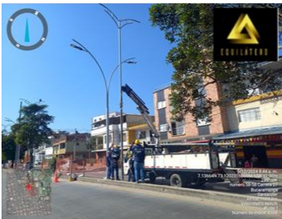
Imagen 1. Instalación de postes
