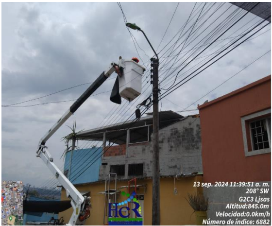
Imagen N°2 Reemplazo de luminaria
