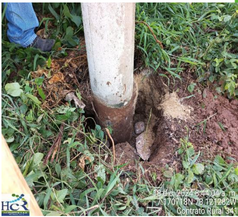
Imagen No 2. Aplome de posteria, tendido de Red aerea y conexión de elementos de soporte y fijación
