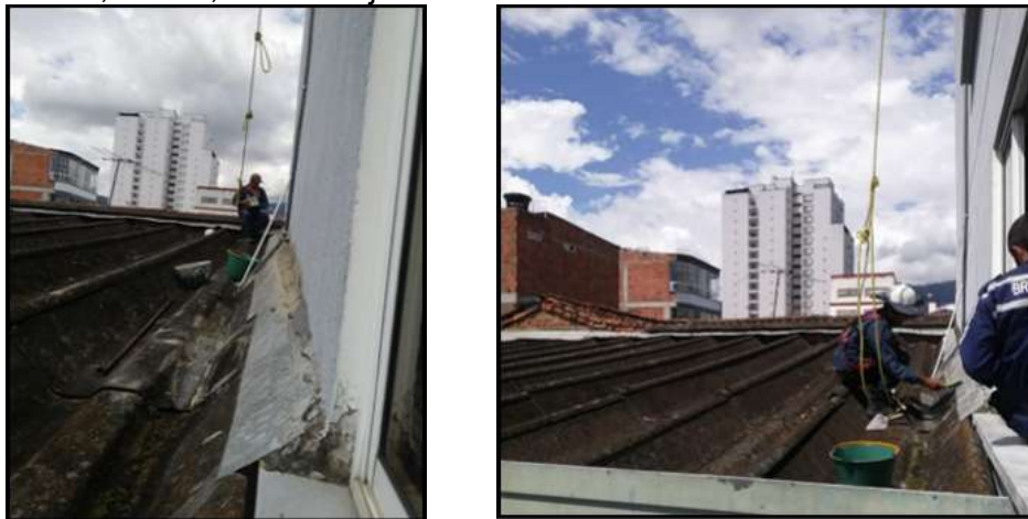
Imagen 10. Limpieza de techo
