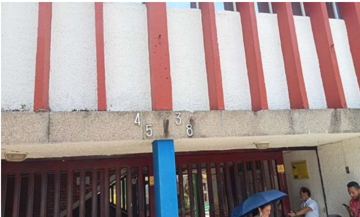
Instalaciones Institución Educativa Bicentenario de la República de Colombia Sede B La Hormiga
