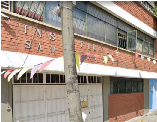
Instalaciones Institución Educativa San Francisco de Asís
