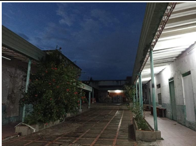
Fotografía 49. Vista de la entrada archivo central -CAIV
