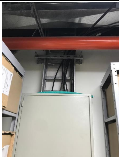
Fotografía 48. Tubería aguas negras
