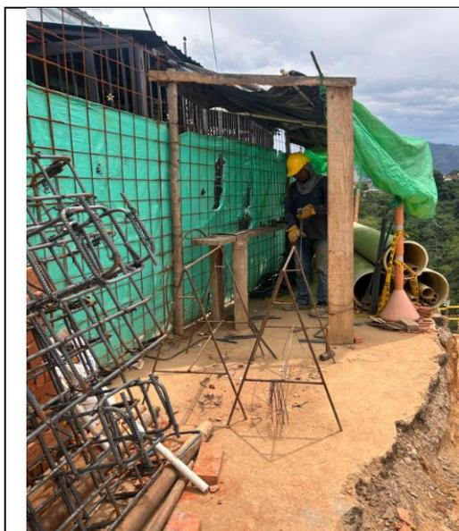
**Imagen:** Figurado de acero refuerzo
