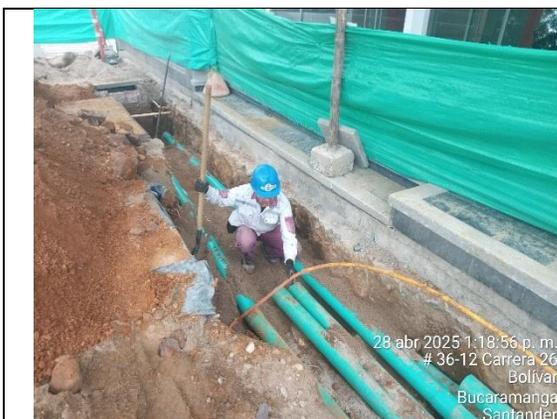
Instalación de cama de arena para ductería eléctrica y comunicaciones en andén occidental carrera 26 calle 36 al frente de edificio Fénix.
