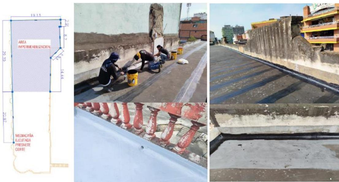
*Figura 1- Rehabilitación de impermeabilización mediante sistema BUR de mediacañas, sobre manto asfáltico con el uso de membrana líquida acrílica. Incluye puente de anclaje de impermeabilización existente, limpieza y acondicionamiento de superficie, reparación de dilataciones y zonas deterioradas e instalación completa de impermeabilización*
