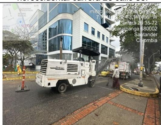
Demolición de pavimento flexible con fresadora en intersección calle 36.
