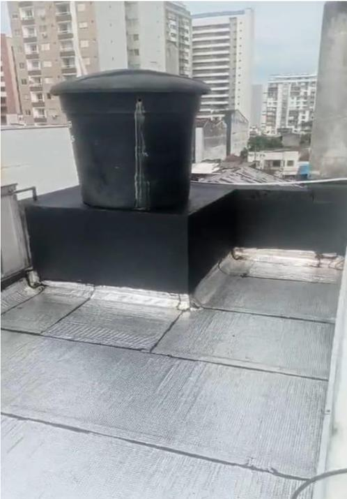
IMAGEN No 1: IMPERMEABILIZACION PLACA DE CUBIERTA
