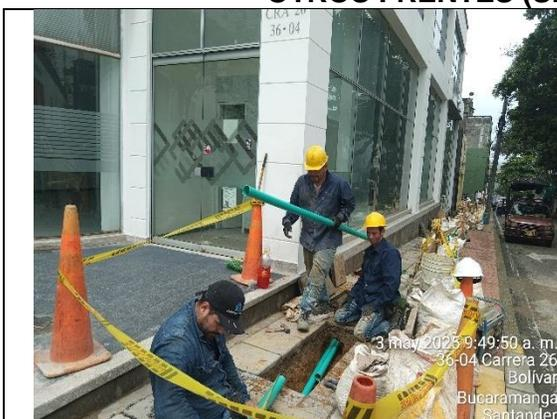
Instalación de ductería para red de semaforización en la calle 36 zona sur.
