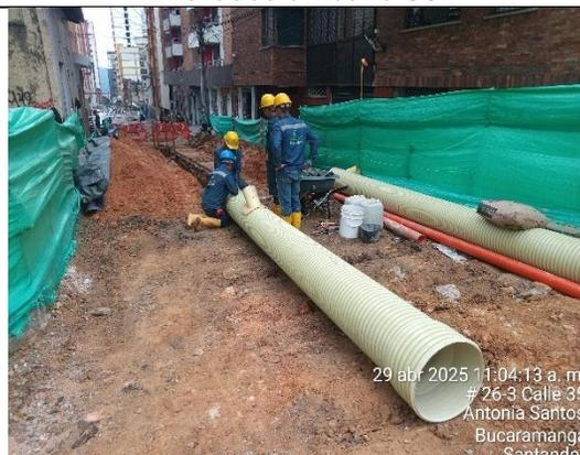
Instalación de tubería Novafort de 12" en intersección calle 35.
