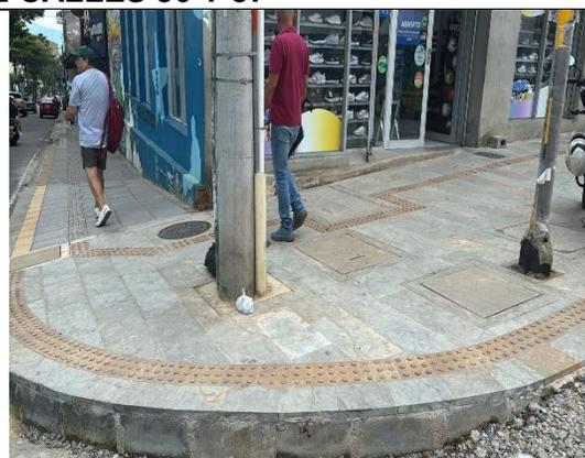
Instalación de loseta royal beta y loseta en concreto, instalación de toperol e instalación de bolardos en zona noroccidental carrera 26 calle 36.
