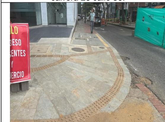
Instalación de loseta royal beta y loseta en concreto, instalación de toperol e instalación de bolardos en zona suroccidental carrera 26 calle 36.
