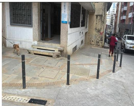
Instalación de loseta royal beta y loseta en concreto, instalación de toperol e instalación de bolardos en zona noroccidental intersección calle 35.
