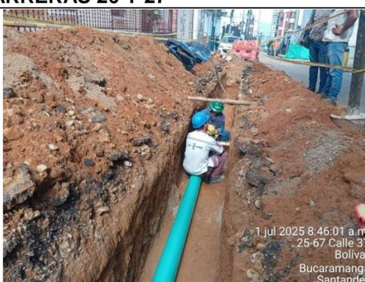
Instalación de ductería eléctrica y de telecomunicaciones en costado sur calle 37 carrera 26.
