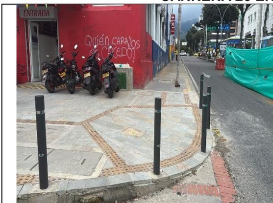
Instalación de loseta royal beta y loseta en concreto, instalación de toperol e instalación de bolardos en zona nororiental carrera 26 calle 36.
