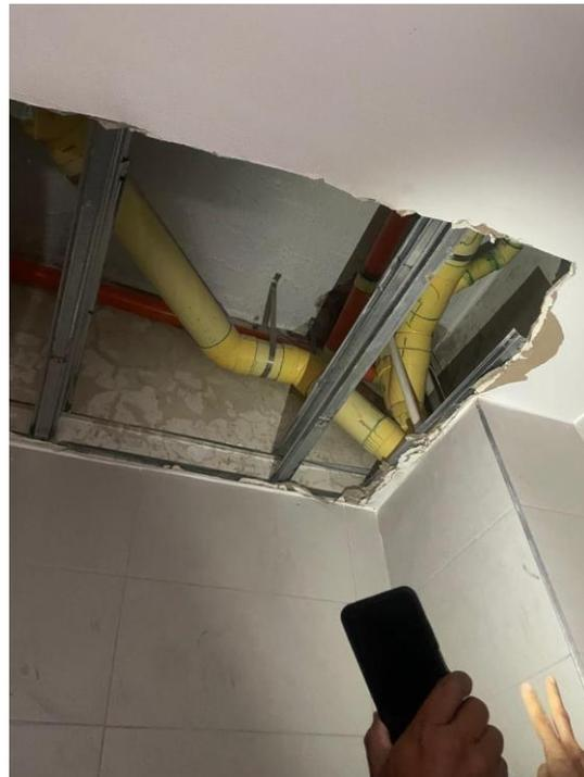
IMAGEN No 2: DEMOLICION CIELO RASO Y REVISION FILTRACIONES
