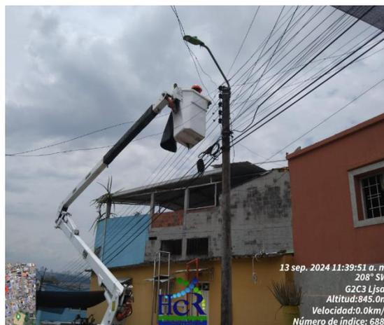
Imagen N°2 Reemplazo de luminaria
