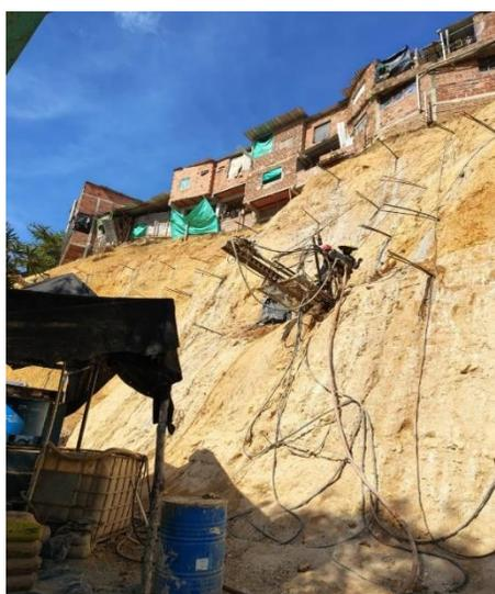
**IMAGEN No 2 . PERFORACIONES E INSTALACION DE ANCLAJES**
