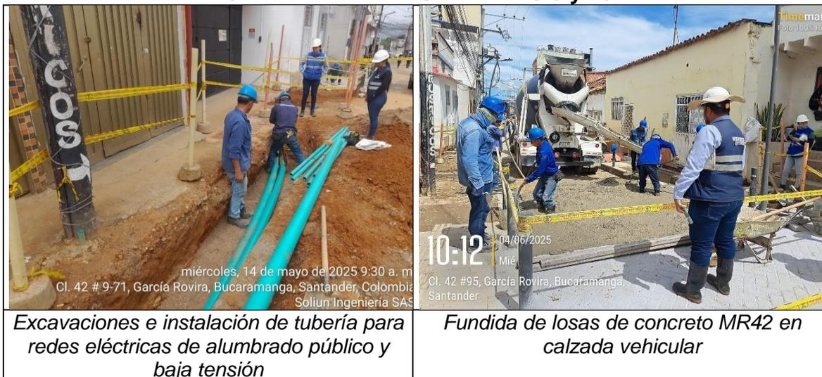
*Excavaciones e instalación de tubería para redes eléctricas de alumbrado público y baja tensión*
