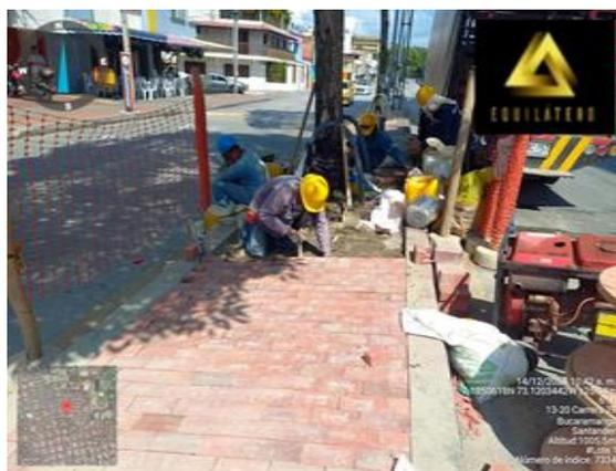
**Imagen 2.** Instalación de adoquín
