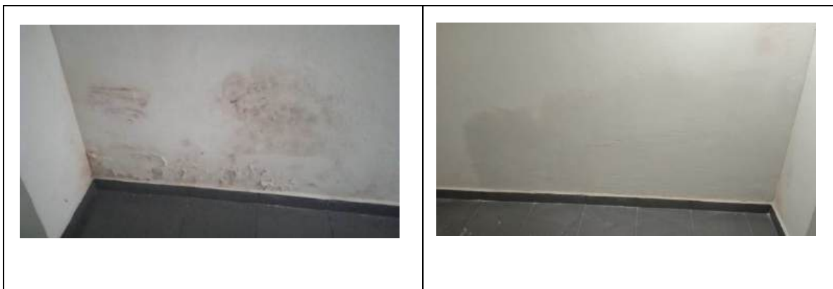
Imagen 10. Arreglo humedad
