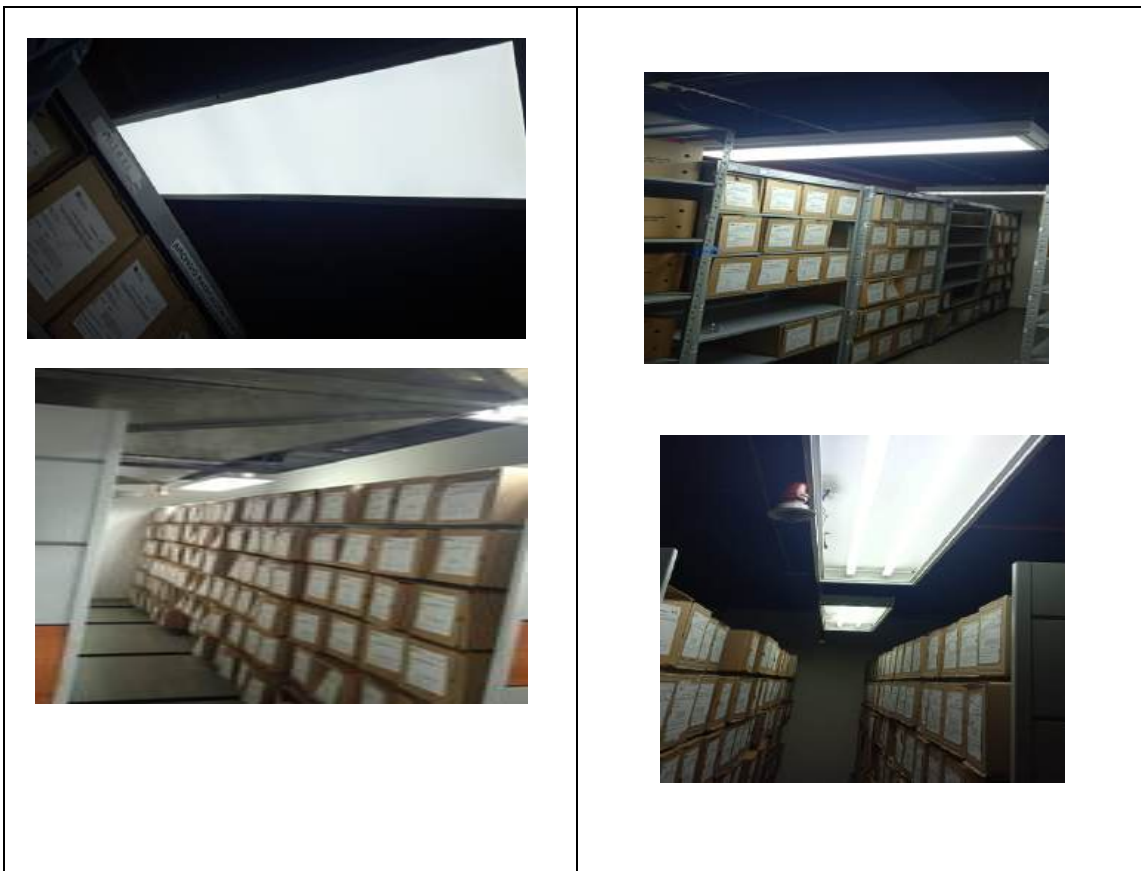
Imagen 2. Cambio de luminarias
