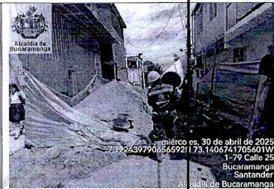
**Imagen 2.** Se observan los cambios de tubos de la red de alcantarillado.
