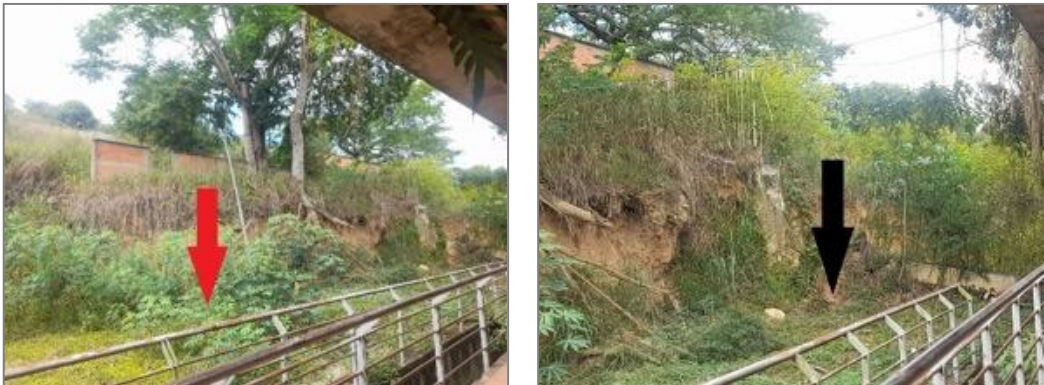
Gráfica 10. Proceso de erosión en el espacio de almacenamiento
