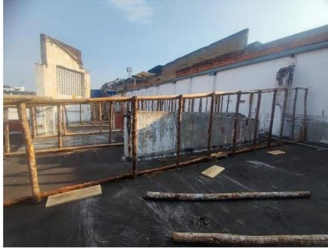
Figura 9 - Evidencia de Actividad 3.1.4 Suministro e instalación de cercha y correas tipo 4 para cubierta en madera rolliza inmunizada  $\varphi=10$  cm
