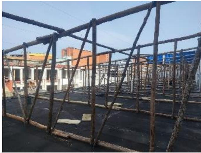
Figura 10 – Evidencia de Actividad 3.1.5 Suministro e instalación de cercha y correas tipo 5 para cubierta en madera rolliza inmunizada  $\varphi=10$  cm
