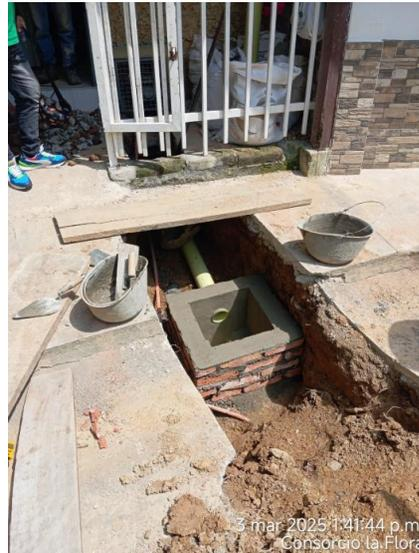
**Imagen:** Instalación de acometidas domiciliarias para la conexión a la red sanitaria
