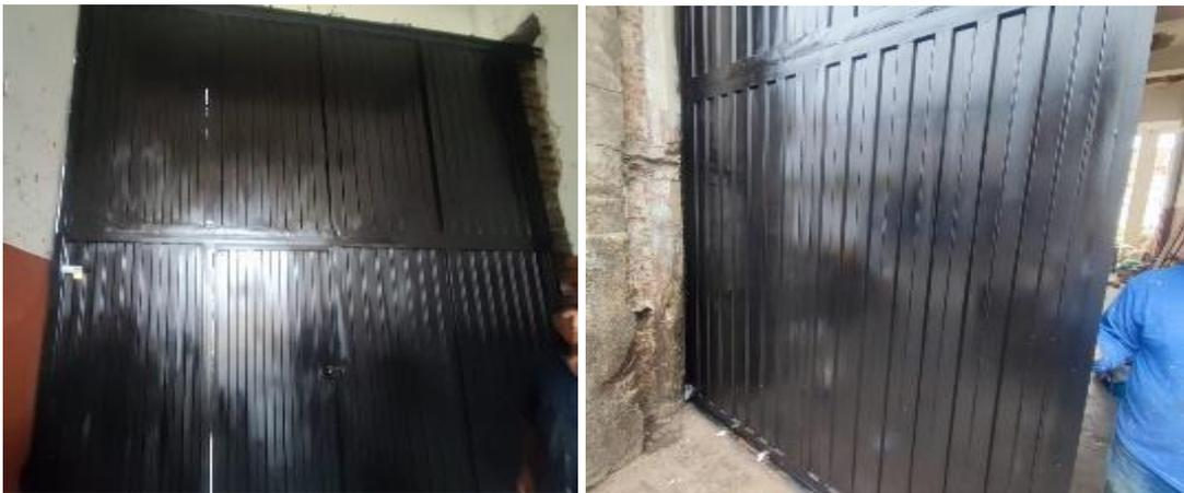
*Figura 13- Evidencia de Actividad 3.1.11 Reparación de portón de ingreso Calle #34. Incluye cambio de riel superior e inferior, reemplazo de lámina metálica en zonas deterioradas por el óxido. Incluye pintura completa e instalación de anticorrosivo*
