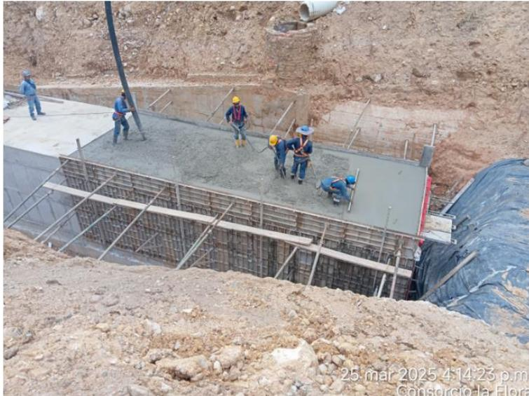
**Imagen:** Construcción box culvert 3x3 mts, módulo 90
