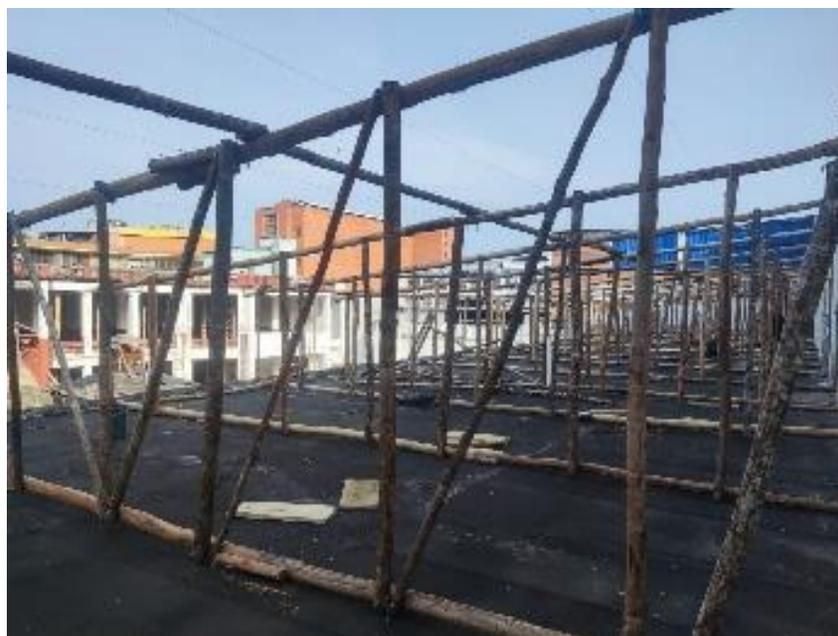
Figura 11 - Evidencia de Actividad 3.1.6 Suministro e instalación de cercha y correas tipo 6 para cubierta en madera rolliza inmunizada  $\varphi=10$  cm
