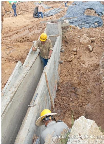
**Imagen:** Construcción de sumideros laterales y transversales
