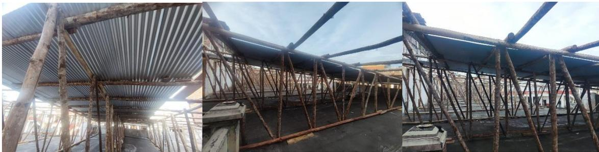
*Figura 5 - Evidencia de Actividad 1.1.6 Suministro e instalación de teja de zinc ondulada 3.048x0.80 m cal 35, incluye elementos de fijación a estructura de madera*
