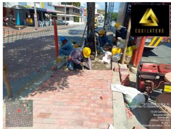
Imagen 2. Instalación de adoquín
