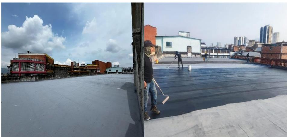
Figura 16 - Evidencia de Actividad 3.1.15 rehabilitación de impermeabilización mediante sistema BUR, sobre manto asfáltico con el uso de membrana líquida acrílica. Incluye puente de anclaje de impermeabilización existente, limpieza y acondicionamiento de superficie, reparación de dilataciones y zonas deterioradas, e instalación completa de impermeabilización.
