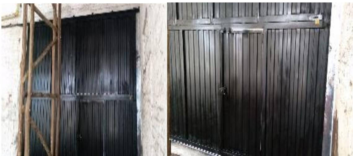
*Figura 14 – Evidencia de Actividad 3.1.12 Reparación de portón de ingreso Cra #16. Incluye cambio de riel superior e inferior, reemplazo de lámina metálica en zonas deterioradas por el óxido. Incluye pintura completa e instalación de anticorrosivo.*
