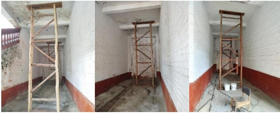
*Figura 3- Evidencia de Actividad 1.1.3 Suministro e instalación de apuntalamiento estructural tipo 2 en madera rolliza inmunizada  $\varphi=10$  cm uniones con puntillas de hierro de 6", tablón inmunizado de 30cm de ancho, 3cm de espesor clavado a estructura con clavos de acero 4".*
