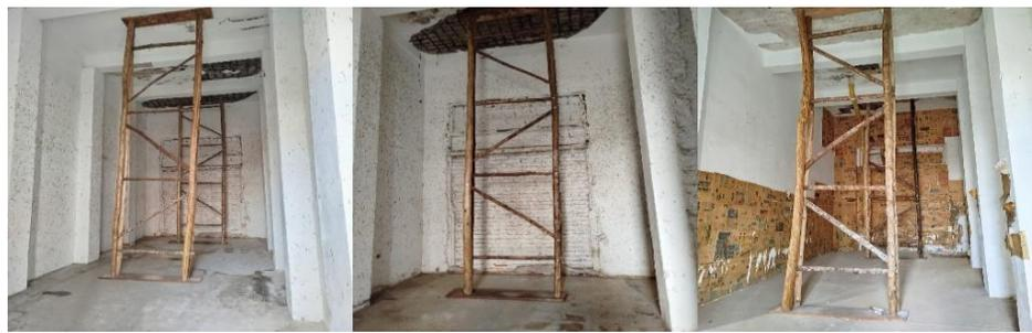
*Figura 4 - Evidencia de Actividad 1.1.4 Suministro e instalación de apuntalamiento estructural tipo 3 en madera rolliza inmunizada  $\varphi=10$  cm uniones con puntillas de hierro de 6", tablón inmunizado de 30cm de ancho, 3cm de espesor clavado a estructura con clavos de acero 4".*
