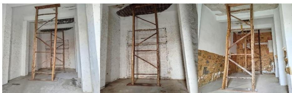
Figura 2- Evidencia de Actividad 1.1.2 Suministro e instalación de apuntalamiento estructural tipo 1 en madera rolliza inmunizada  $\varphi=10$  cm uniones con puntillas de hierro de 6", tablón inmunizado de 30cm de ancho, 3cm de espesor clavado a estructura con clavos de acero 4".
