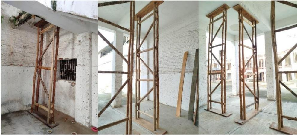
Figura 7 - Evidencia de Actividad 3.1.1 Suministro e instalación de apuntalamiento estructural tipo 4 en madera rolliza inmunizada  $\varphi=10$  cm uniones con puntillas de hierro de 6", tablón inmunizado de 30cm de ancho, 3cm de espesor clavado a estructura con clavos de acero 4".
