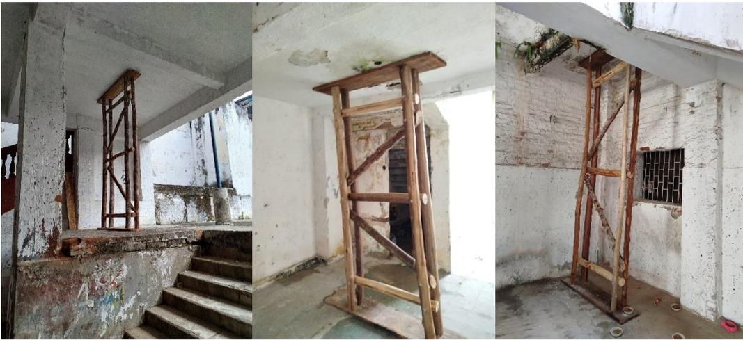
Figura 8 - Evidencia de Actividad 3.1.1 Suministro e instalación de apuntalamiento estructural tipo 5 en madera rolliza inmunizada  $\varphi=10$  cm uniones con puntillas de hierro de 6", tablón inmunizado de 30cm de ancho, 3cm de espesor clavado a estructura con clavos de acero 4".
