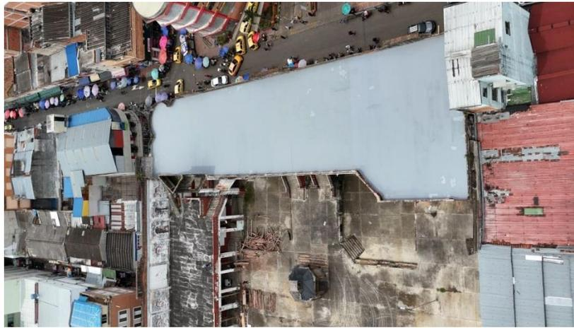
Figura 15 - Evidencia de Actividad 3.1.14 rehabilitación de impermeabilización mediante sistema BUR de media cañas, sobre manto asfáltico con el uso de membrana líquida acrílica. Incluye puente de anclaje de impermeabilización existente, limpieza y acondicionamiento
