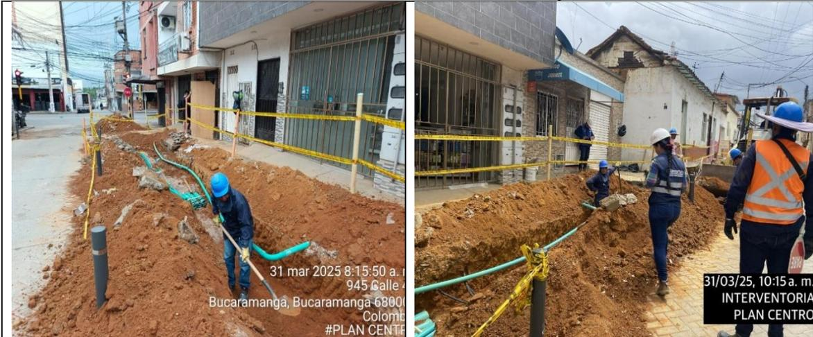
*Excavaciones e instalación de tubería para redes eléctricas de alumbrado público y baja tensión*
