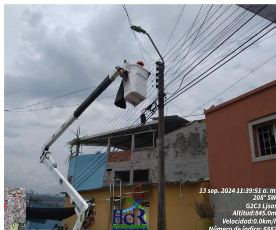
Imagen N°2 Reemplazo de luminaria
