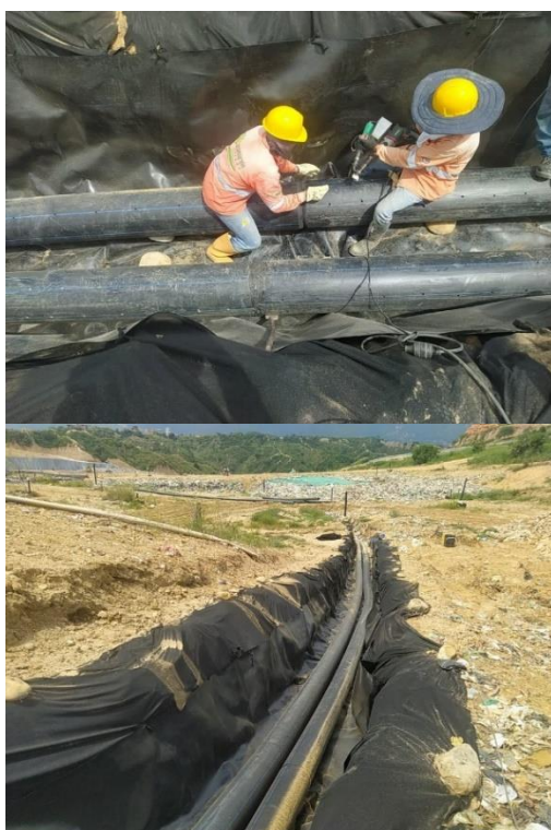
Ilustración. Construcción subdrén tipo 2 etapa 1E y subdrenes tipo 3 y 4 de la etapa 1F, octubre 2024
