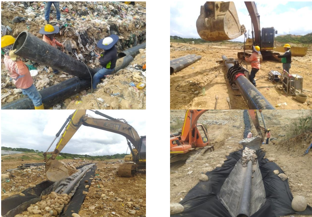
Ilustración. Construcción subdrenes de recolección de lixiviados, noviembre 2024
