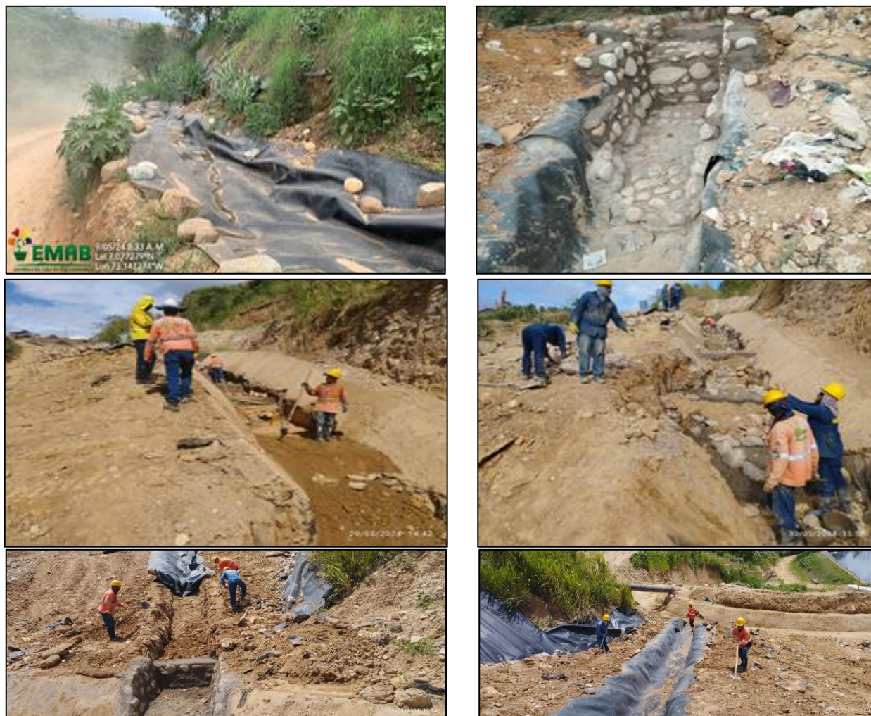
Ilustración. Mantenimiento de canales de aguas lluvias, mayo de 2024
