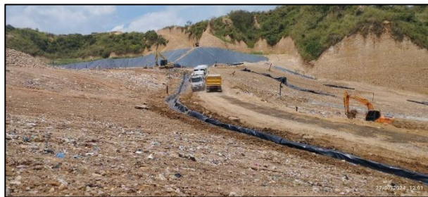
Ilustración. Construcción canal con geocelda N° 1 y canal sup. con geomembrana HDPE cal. 40 mils, julio 2024
