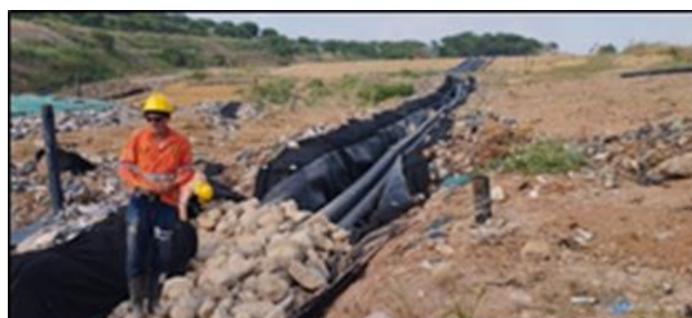
Ilustración. Construcción de sistema de drenaje etapas 1E y 1F, abril de 2024
