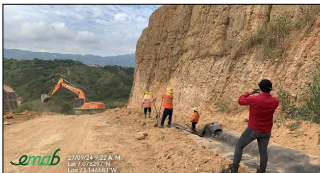
Ilustración. Construcción canal en concreto N°2 y canales sup. con geomembrana HDPE cal. 40 mils, septiembre 2024
