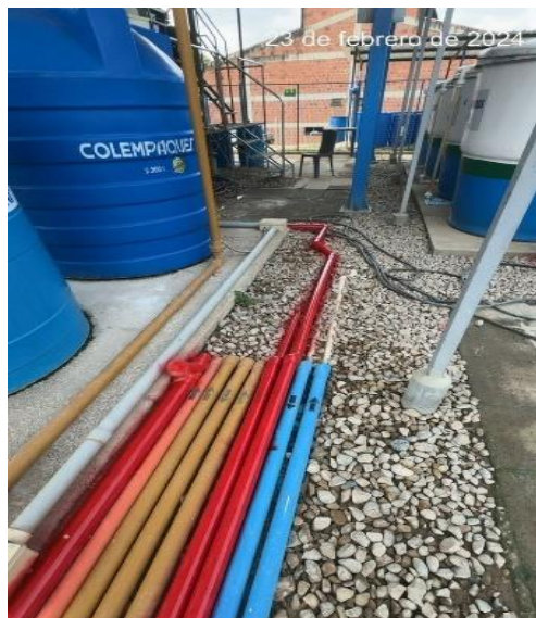
Mantenimiento tuberías PTLX- Recubrimiento con pintura
