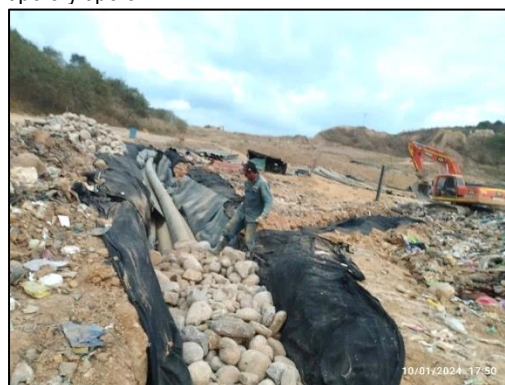
Construcción de subdrenes tipo 3 y tipo 5
