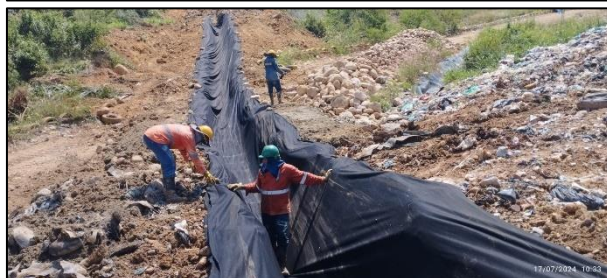
Ilustración. Construcción de subdrenes tipo 5 y tipo 3, julio de 2024
