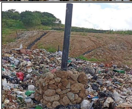
Ilustración. Realce y construcción de chimeneas celda actual de disposición.
