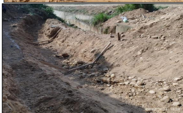
Construcción canales para manejo de aguas lluvias y de escorrentía en la Zona 1 Cárcava 1, zona 2 cárcava 1 y celda 4
