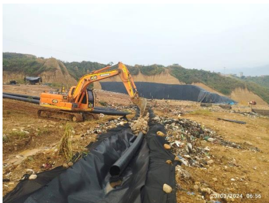
Ilustración. Construcción de sistema de drenaje etapas 1D y 1E, marzo de 2024
