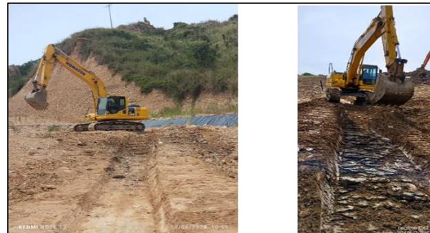
Ilustración. Construcción canal con geocelda N° 1, canal en concreto N°2 y canal sup. con geomembrana HDPE cal. 40 mils, agosto 2024
