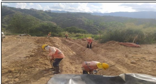
Ilustración. Construcción canal en concreto N°2 y canales sup. con geomembrana HDPE cal. 40 mils, septiembre 2024
