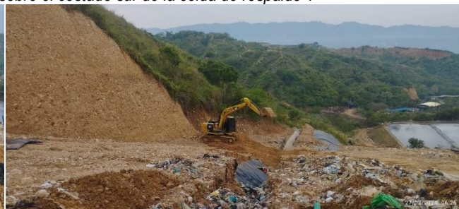
Construcción de Canales en geomembrana sobre el costado sur de la celda de respaldo 1
