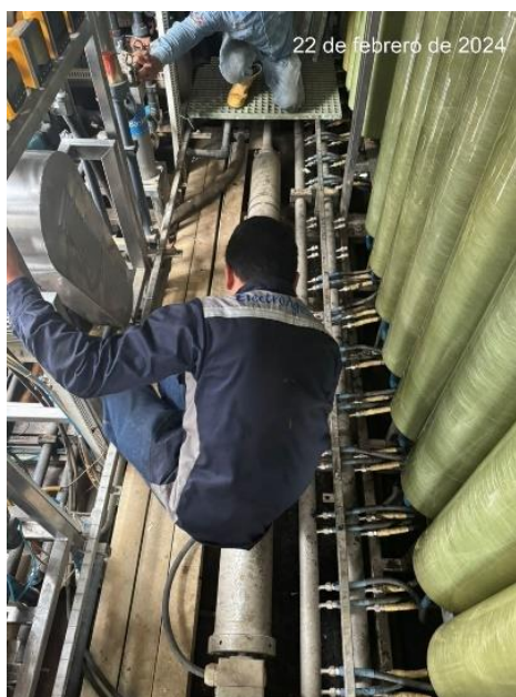
Mantenimiento preventivo bomba de alta presión Grundfos de la DTRO
