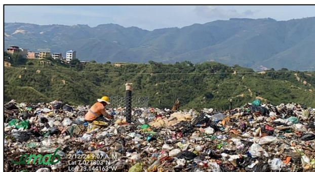
Ilustración. Realce y construcción de chimeneas celda actual de disposición.
