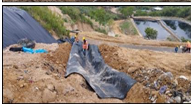
Ilustración. Construcción canal con geocelda N°.3 y canal superficial con geomembrana HDPE calibre 40 mils, abril 2024
