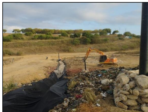
Construcción de subdrenes tipo 3 y tipo 5
