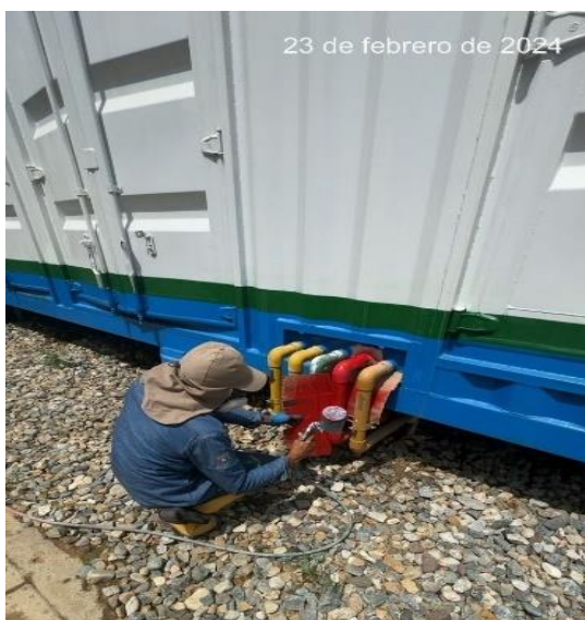
Mantenimiento tuberías PTLX- Recubrimiento con pintura
