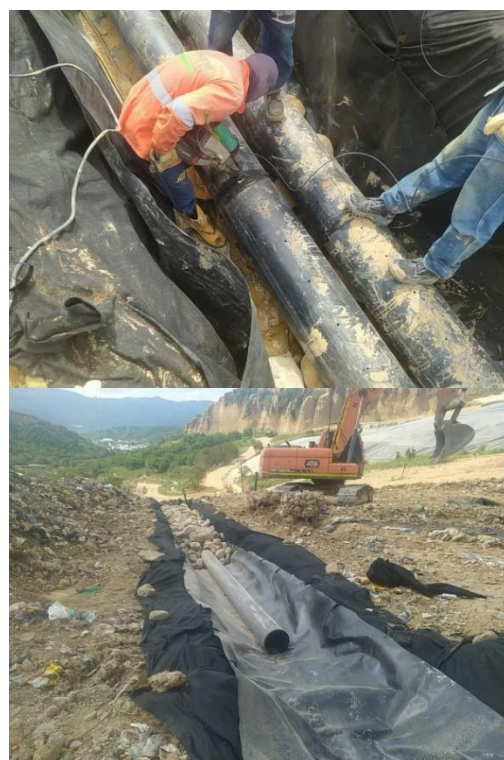
Ilustración. Construcción subdrén tipo 2 etapa 1E y subdrenes tipo 3 y 4 de la etapa 1F, octubre 2024
