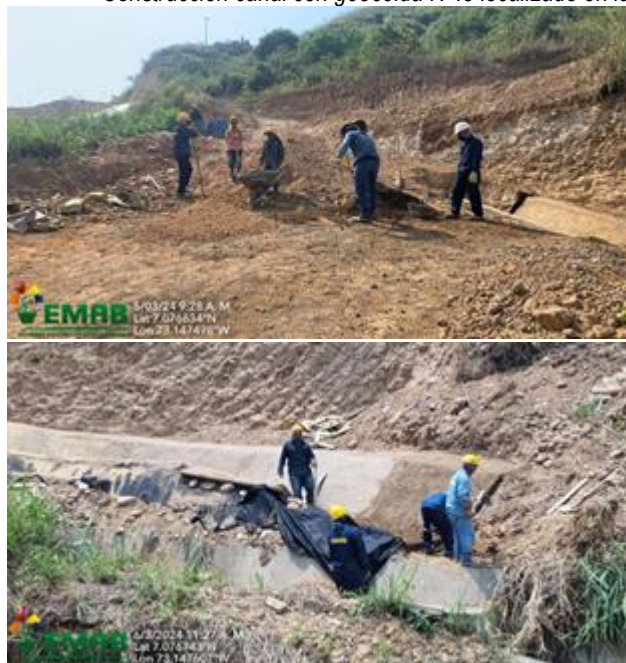
Construcción de Canales en geomembrana sobre el costado sur de la celda de respaldo 1
