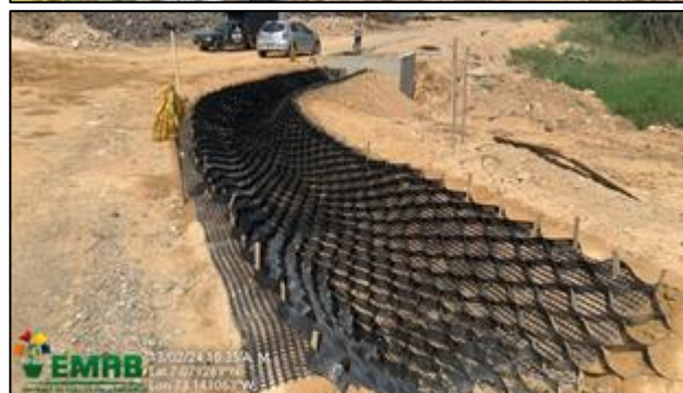
Ilustración. Construcción canales para manejo de aguas lluvias y escorrentía, febrero de 2024
