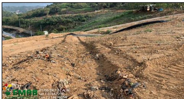
Ilustración. Construcción canal con geocelda N° 1, canal en concreto N°2 y canal sup. con geomembrana HDPE cal. 40 mils, agosto 2024
