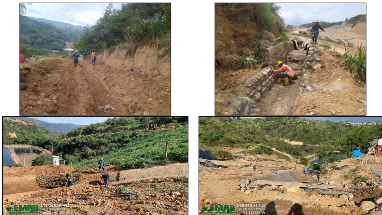
Ilustración. Mantenimiento canal en geomembrana HDPE cal. 40 mils, agosto 2024
