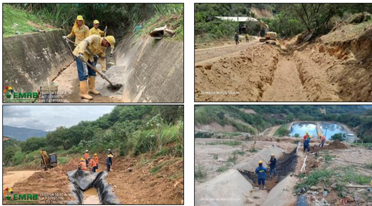
Ilustración. Mantenimiento de canales de aguas lluvias, julio de 2024
