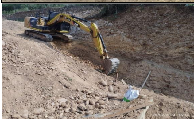
Construcción canales para manejo de aguas lluvias y de escorrentía en la Zona 1 Cárcava 1, zona 2 cárcava 1 y celda 4
