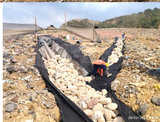
Ilustración. Construcción de sistema de drenaje etapas 1D y 1E, marzo de 2024
