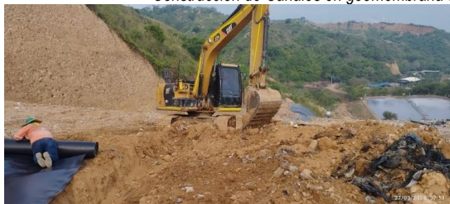
Construcción de Canales en geomembrana sobre el costado sur de la celda de respaldo 1
