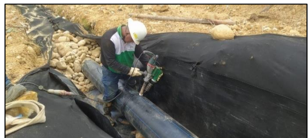
Ilustración. Construcción de subdrenes tipo 5 y tipo 3, julio de 2024
