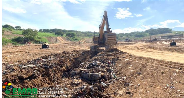
Ilustración. Construcción de subdrén tipo 2, agosto de 2024
