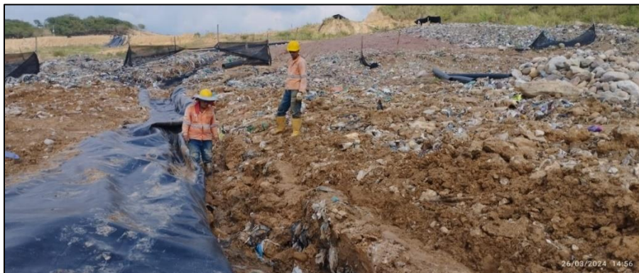
Ilustración. Construcción canales para manejo de aguas lluvias y escorrentía, marzo de 2024
