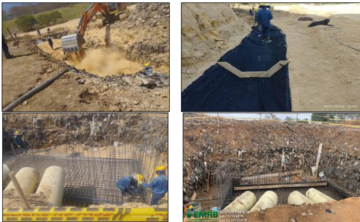
Ilustración. Construcción canales para manejo de aguas lluvias y escorrentía, enero de 2024
