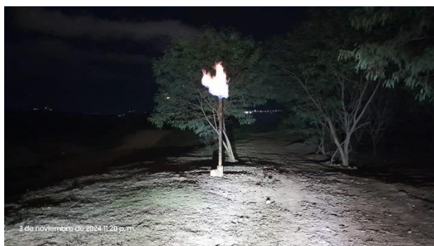
Ilustración. Verificación de chimeneas encendidas.
