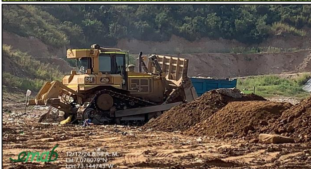
Ilustración Cobertura de residuos sólidos con lona sintética y con material terroso o granular
