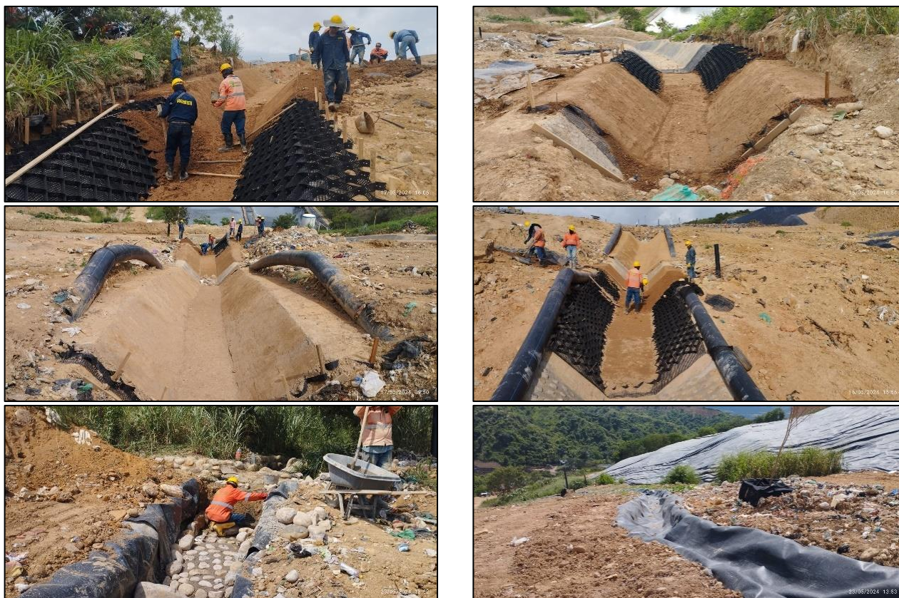
Ilustración. Construcción canal con geocelda N°.1, canal central y canal sup. con geomembrana HDPE cal. 40 mils, mayo 2024
