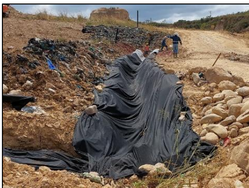
Construcción de subdrenes tipo 3 y tipo 5
