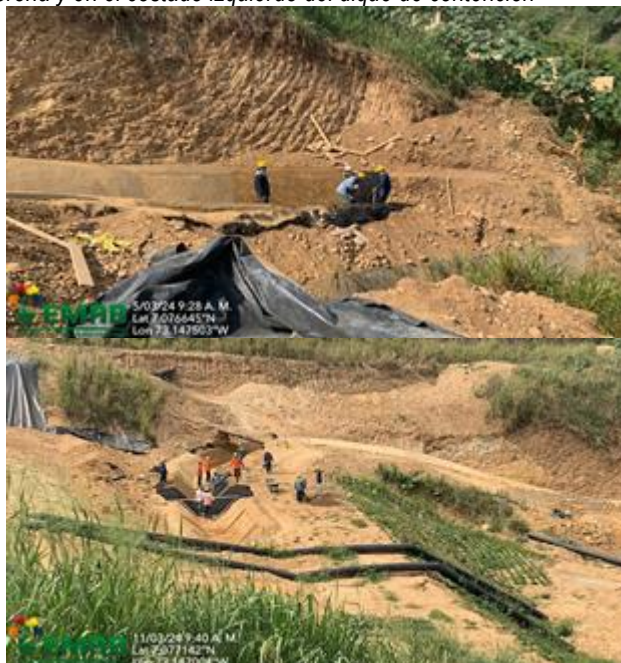
Construcción de Canales en geomembrana sobre el costado sur de la celda de respaldo 1
