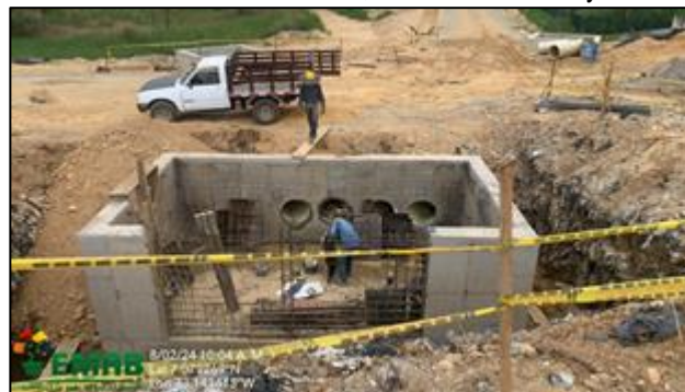
Construcción canales para manejo de aguas lluvias y de escorrentía en la Zona 1 Cárcava 1, zona 2 cárcava 1 y celda 4
