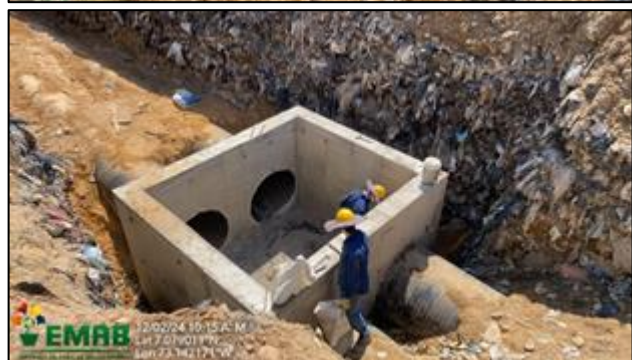
Ilustración. Construcción canales para manejo de aguas lluvias y escorrentía, febrero de 2024
