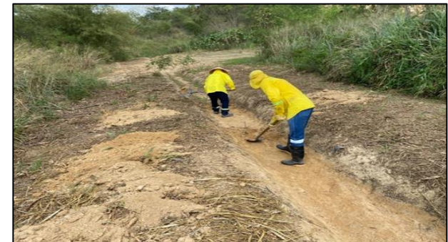
Ilustración. Limpieza de los canales de aguas lluvias, 2024
