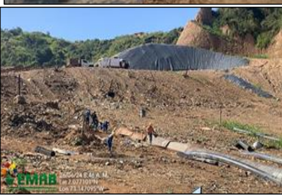
Ilustración. Construcción canal central y canal con geocelda N°1, junio de 2024
