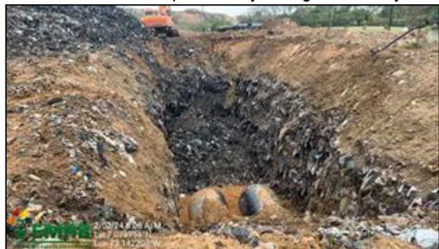
Construcción canales para manejo de aguas lluvias y de escorrentía en la Zona 1 Cárcava 1, zona 2 cárcava 1 y celda 4
