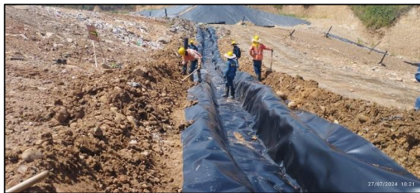
Ilustración. Construcción canal con geocelda N° 1 y canal sup. con geomembrana HDPE cal. 40 mils, julio 2024
