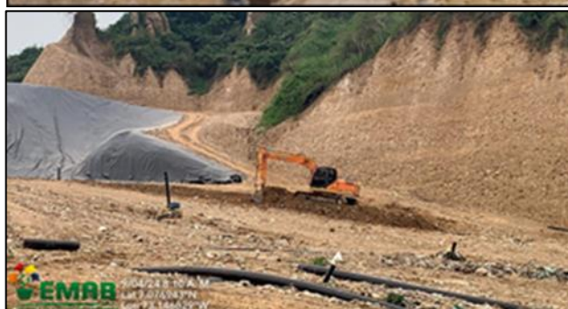
Ilustración. Construcción canal con geocelda N°.3 y canal superficial con geomembrana HDPE calibre 40 mils, abril 2024
