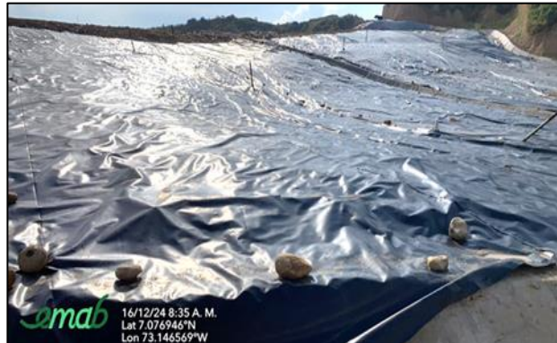
Ilustración. Actividades de cierre y clausura celda de contingencia y celda de respaldo 1, 2024
