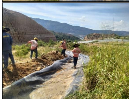
Ilustración. Mantenimiento de canales de aguas lluvia y de escorrentía, octubre de 2024
