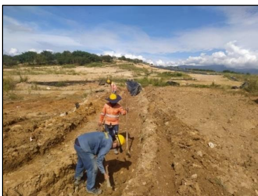
Ilustración. Mantenimiento de canales de aguas lluvia y de escorrentía, octubre de 2024
