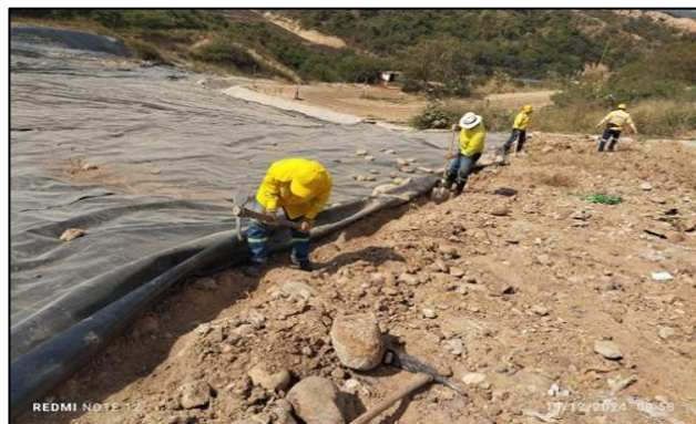
Ilustración. Actividades de cierre y clausura celda de contingencia y celda de respaldo 1, 2024
