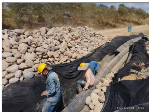
Construcción de subdrenes tipo 3 y tipo 5
