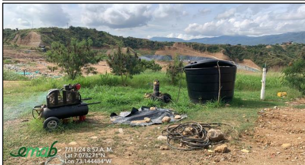
Ilustración. Actividades de extracción forzada de lixiviados
