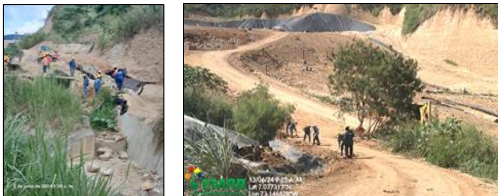
Ilustración. Mantenimiento de canales de aguas lluvias, junio de 2024
