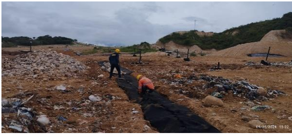
Ilustración. Construcción de subdrenes tipo 2 y tipo 3, mayo de 2024
