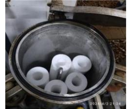
Mantenimiento de la unidad de microfiltración y las membranas propias del equipo
