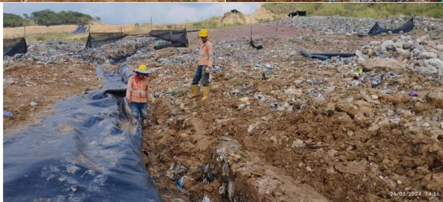
*Ilustración 3 Construcción canales para manejo de aguas lluvias y escorrentía, marzo de 2024*
