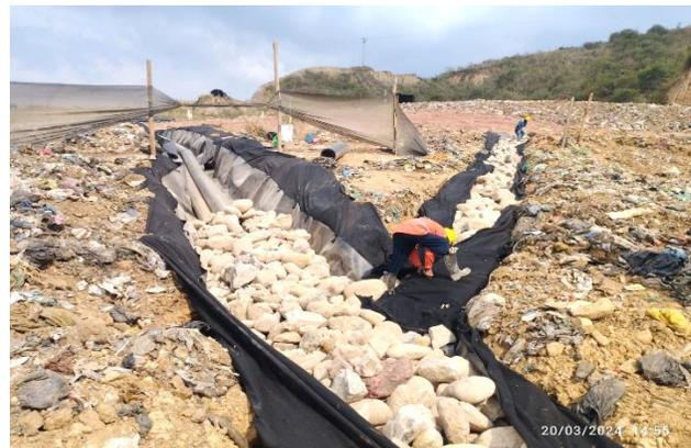
*Ilustración. Construcción de sistema de drenaje etapas 1D y 1E, marzo de 2024*
