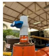
Reemplazo válvulas para limpiezas de las tuberías de las bombas #1 y #2
