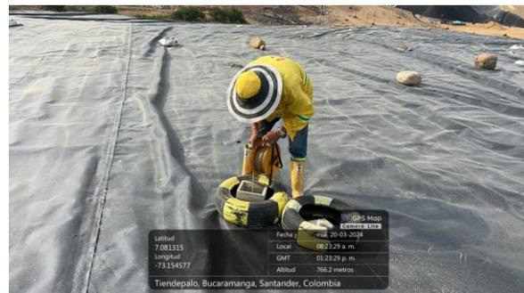
Ilustración. Lectura de Piezómetros de sonda geo eléctrica
