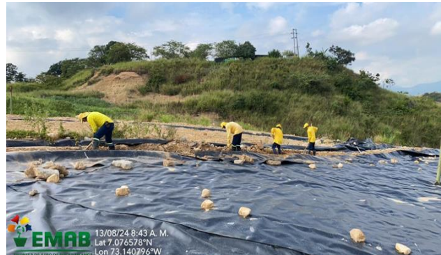
Ilustración. Actividades de cierre y clausura celda de contingencia y celda de respaldo 1
