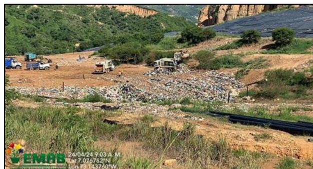
Ilustración. Disgregación y compactación de residuos sólidos en la celda actual
