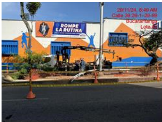
Imagen 1. Instalación de postes
