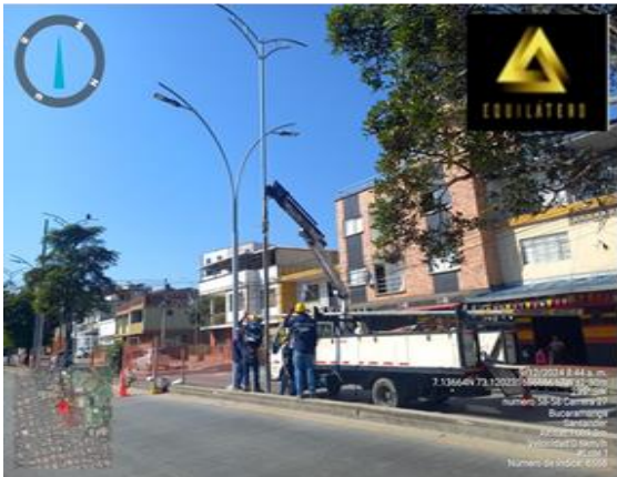
Imagen 1. Instalación de postes
