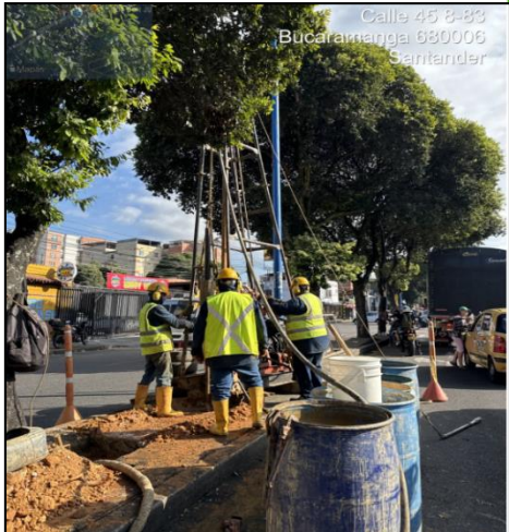
Figura 2 Exploración geotécnica Directa
