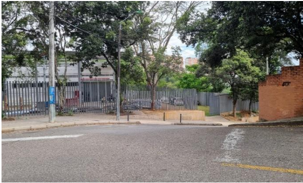
ACTUAL: Encerramiento calle 70 sur vía antigua
