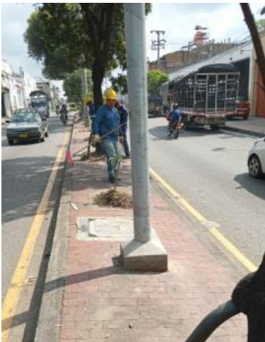
Imagen No.2. Limpieza de la obra
