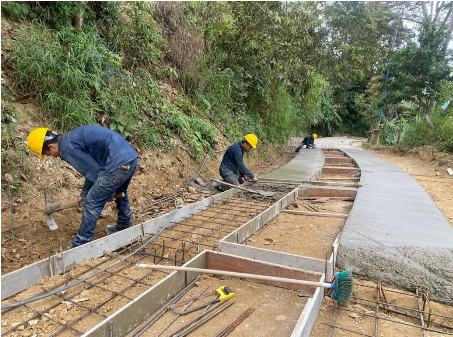
Construcción de Placa Huella en la Vereda Cuchilla Alta
