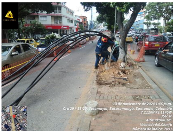
Imagen 2. Tendido de redes
