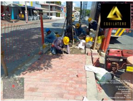
Imagen 2. Instalación de adoquín
