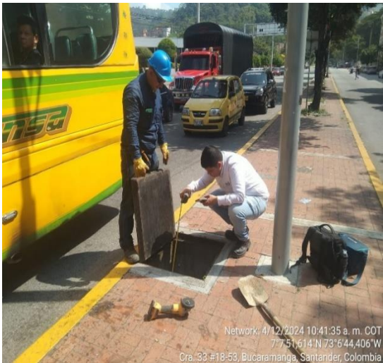
Imagen No.1. Inspección RETIE
