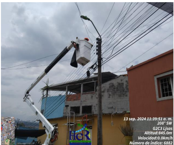
Imagen N°2 Reemplazo de luminaria
