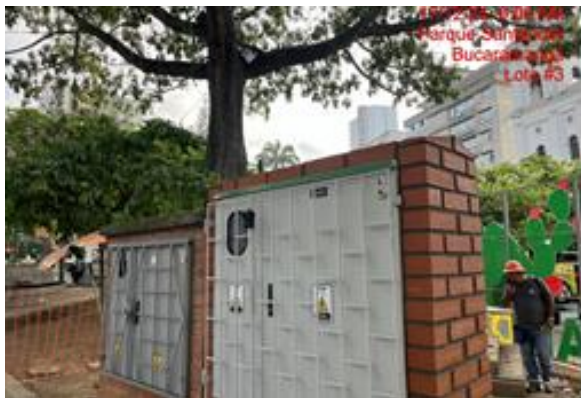
Imagen 2. Construcción de tablero
