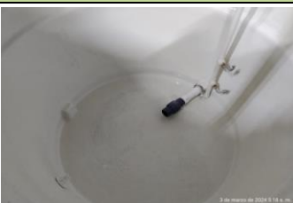
Limpieza del tanque de permeado DTRO, OR y C&P de la OR
