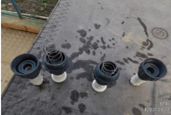
Reemplazo resortes de las válvulas antirretorno ubicadas en la zona de inyección de químico del DAF
