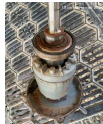
Cambio de rodamientos bomba del C&P de la OR
