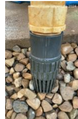
Inspección y limpieza del pie de válvula de la bomba del pozo, tanque alimentación y salida DAF
