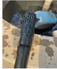
Inspección y limpieza del pie de válvula de la bomba del pozo, tanque alimentación y salida DAF
