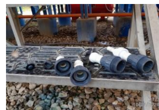
Limpieza de los cheques antirretorno del DAF
