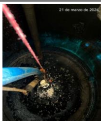
Extracción de lodos sedimentados en el tanque alimentación y salida DAF y tanque de concentrados
