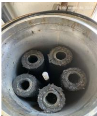
Mantenimiento de la unidad de microfiltración y las membranas propias del equipo
