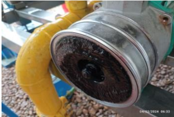
Inspección y limpieza de la bomba de recirculación del DAF
