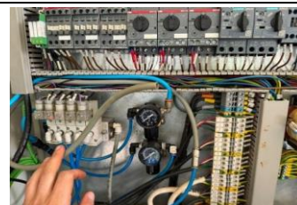
Reemplazo manguera neumática en el tablero del DAF
