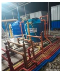
Inyección limpiador ácido para limpieza de los tramos de tubería de succión y descarga de la Bomba #2, #4, #7
