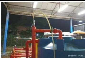
Limpieza química del tubo floculador
