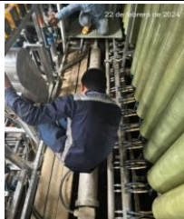
Mantenimiento preventivo bomba de alta presión Grundfos de la DTRO
