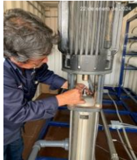
Cambio sello mecánico de la bomba de alta presión de la OR
