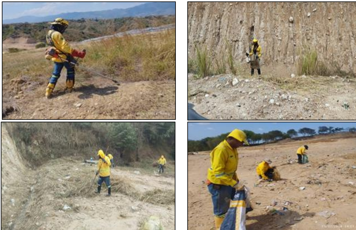
Actividades de cierre y clausura celda de contingencia y celda de respaldo 1, primer trimestre 2024
