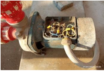
Reemplazo bomba de concentrados por falla eléctrica
