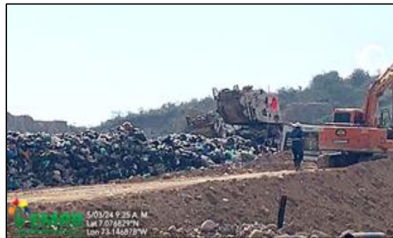
Disgregación y compactación de residuos sólidos en la celda actual
