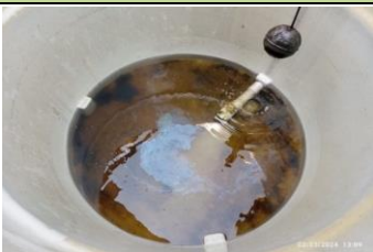
Limpieza del tanque de permeado DTRO, OR y C&P de la OR
