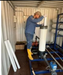
Cambio cartuchos de microfiltración y mantenimiento de las membranas de la OR
