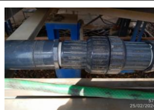
Reemplazo de la válvula de retención ubicada en el circuito de recirculación del DAF
