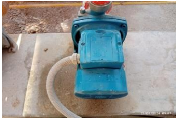
Reemplazo bomba de concentrados por falla eléctrica
