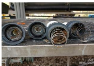
Limpieza de los cheques antirretorno del DAF
