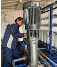
Cambio sello mecánico de la bomba de alta presión de la OR
