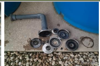
Inspección y limpieza de la bomba de recirculación del DAF
