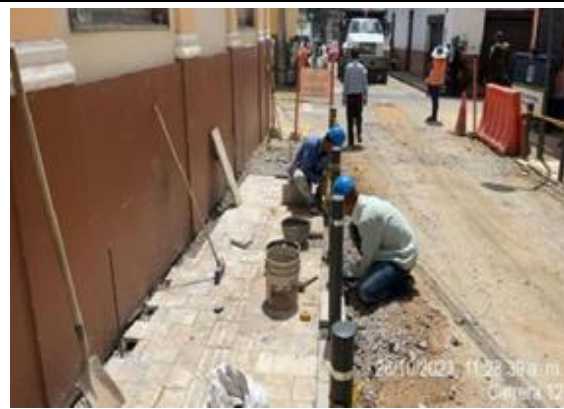
Extendida capa de sub -base e instalación piso peatonal en travertino
