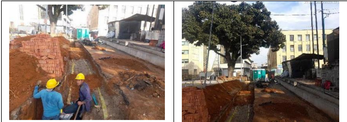
Excavaciones para instalación de ductos carrera 11 entre calles 36 y 37
