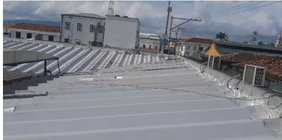
Impermeabilización Cubierta CAIV
