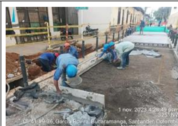
Instalación tramo de monoblock
