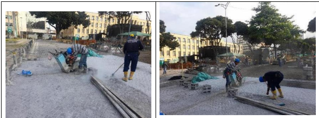
Corte para dilataciones de losas concreto MR-42 carrera 11 con calle 36
