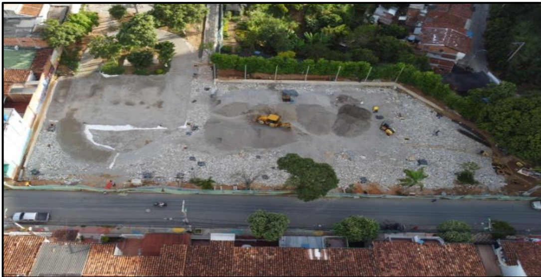
MEJORAMIENTO DEL SUELO DEL PATINODROMO, CANCHA Y PARQUE
