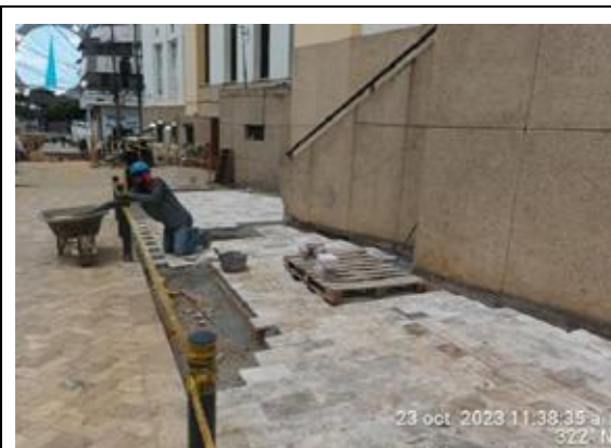
Piso peatona en travertino costado norte
