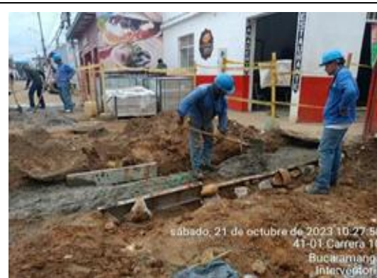
Atraque en concreto tubería eléctrica
