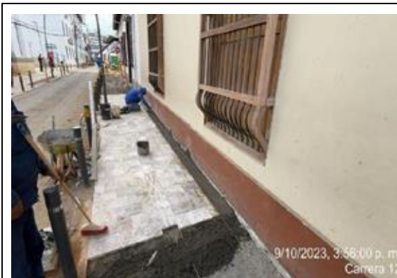
Instalación piso peatonal en travertino
