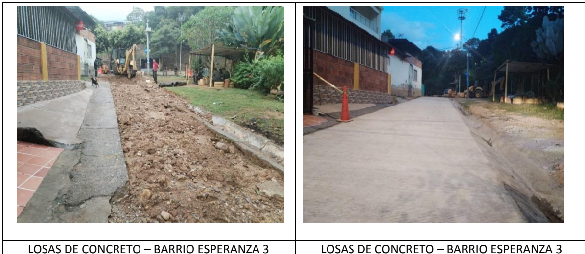
LOSAS DE CONCRETO – BARRIO ESPERANZA 3
