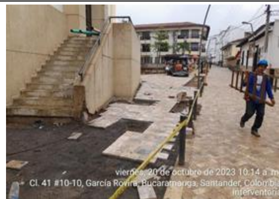
Instalación piso peatonal en travertino
