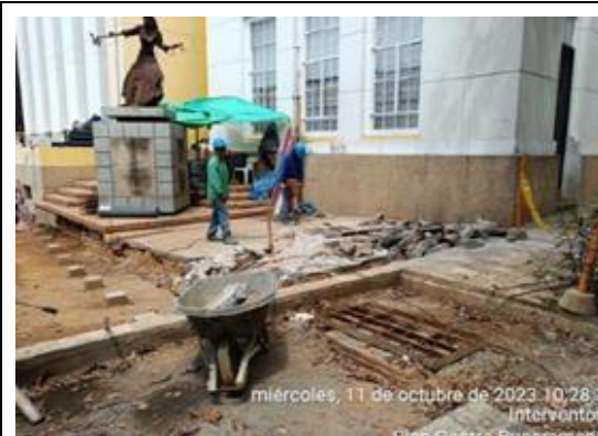
Demolición plaza zona del deck
