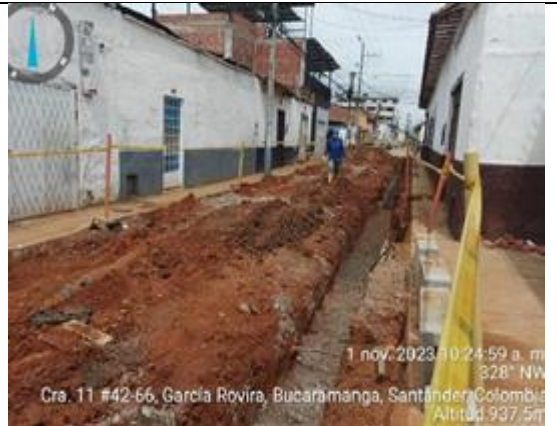
Excavaciones para sardinel
