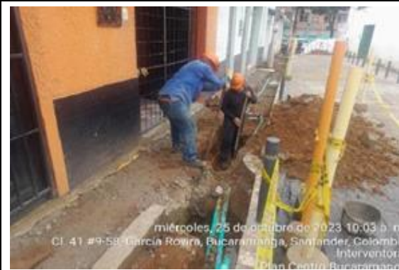
Excavaciones tubería eléctrica
