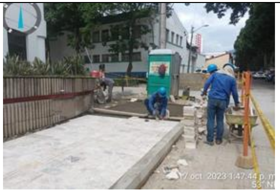
Instalación piso peatonal sobre la calle 44
