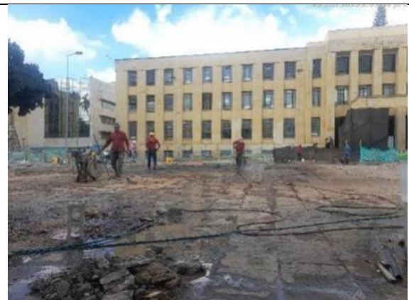
Lavado de piedra Barichara para instalación de brechado
