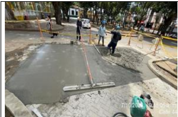
Fundida tramo calzada en concreto liso
