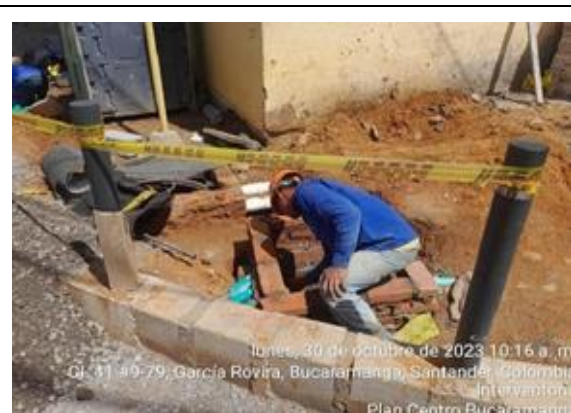
Construcción caja de alumbrado publico
