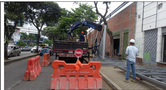
ACTUAL: izajes estructura metalica sobre la carrera 33
