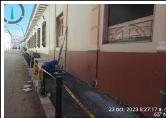
Extendida capa de sub -base e instalación piso peatonal en travertino
