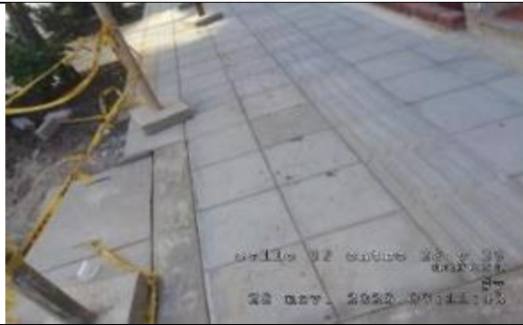
CALLE 32 ENTRE 28 Y 29 COSTADO SUR
