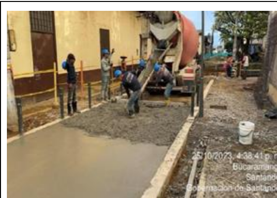
Fundida losas pavimento MR-42
