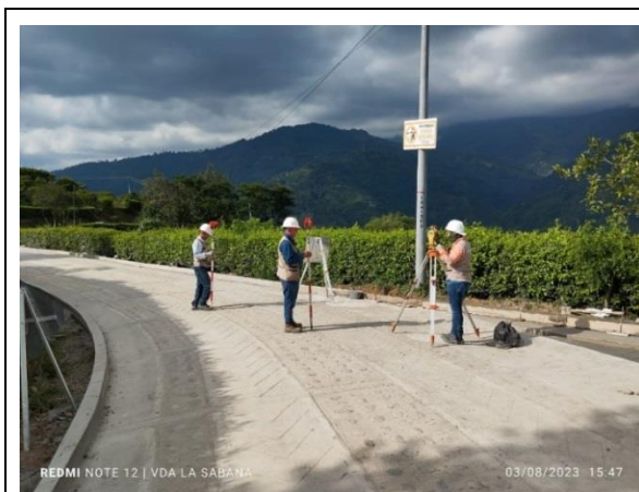
PLACA HUELLA VEREDA LA SABANA
