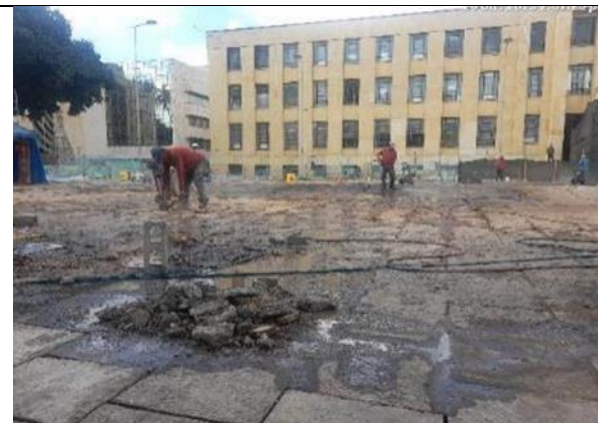
Lavado de piedra Barichara para instalación de brechado
