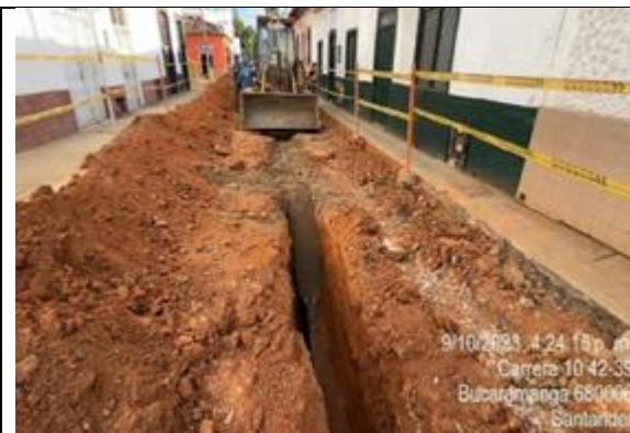
Instalación geodren vial
