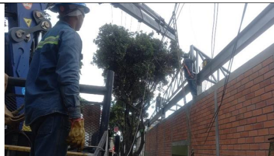
ACTUAL: izajes estructura metalica sobra la carrera 33a
