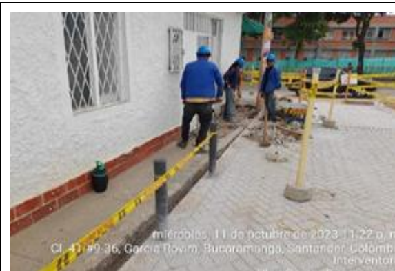
Demolición tramo placa de andén
