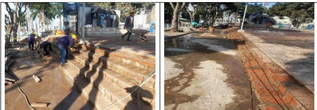
Refuerzo escalera calle 36 plazoleta.
