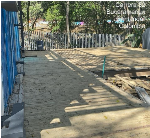
Instalación de piso en pino
