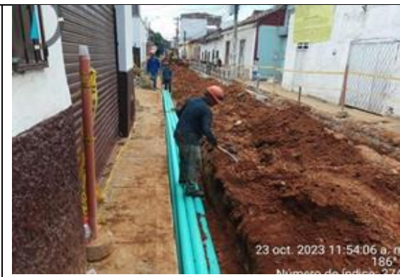
Instalación tubería eléctrica
