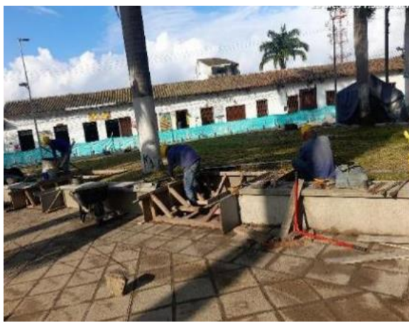
Instalación de acero y malla electro soldada para bancas
