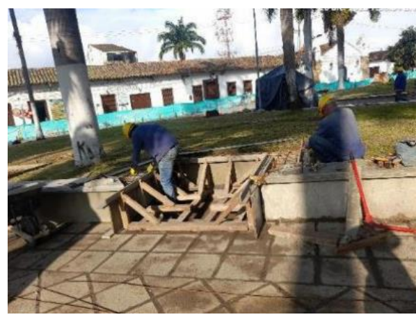
Instalación de acero y malla electro soldada para bancas
