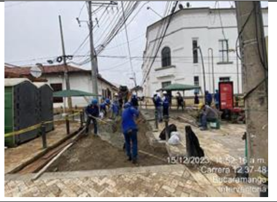
Conformación capa de rasante calzada vehicular en intersección con calle 41
