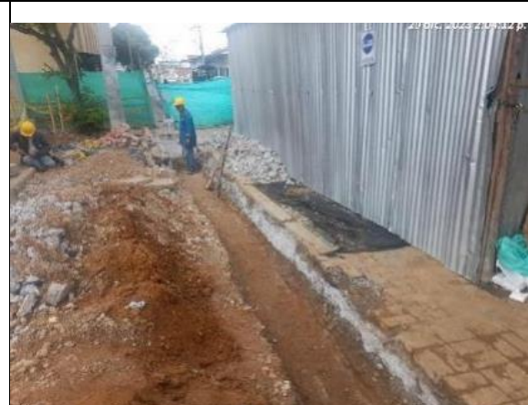
Demolición placa de piso y excavación en zanja para instalación de sardineles carrera 12 con calle 35
