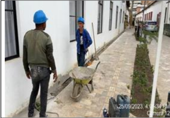
Adecuación desagüe bajantes
