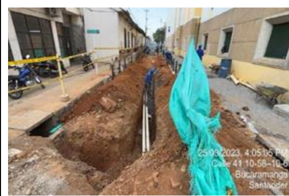
Instalación tubería del acueducto
