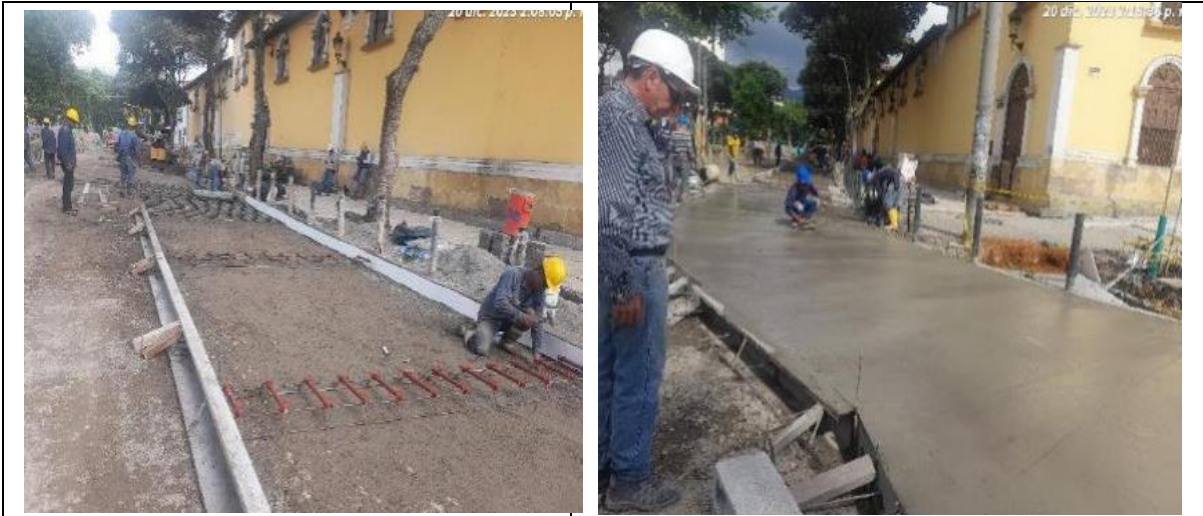
Instalación de concreto MR-42 calle 36 entre carreras 11 y 12
