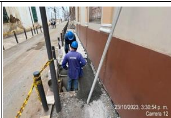
Adecuación cajas eléctricas
