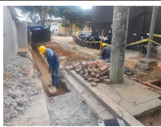
Demolición placa de piso y excavación en zanja para instalación de sardineles carrera 12 con calle 35
