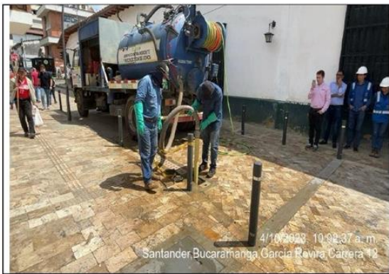
Pruebas de limpieza canales de monoblock
