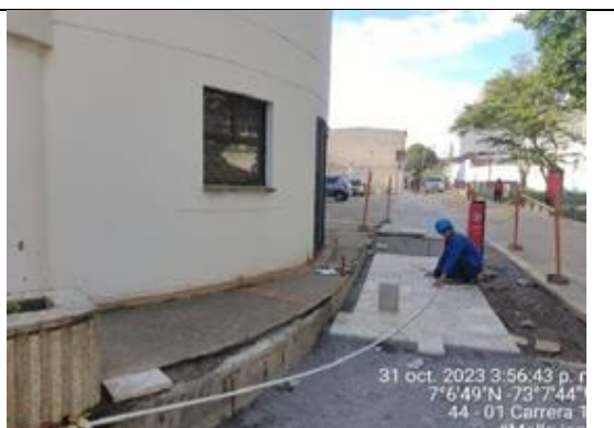
Instalación piso peatonal en travertino
