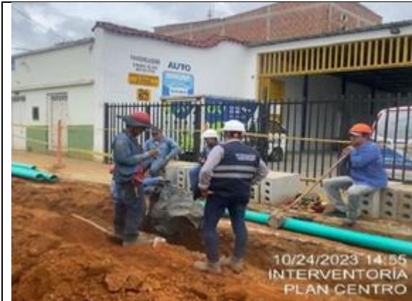
Instalación tubería eléctrica
