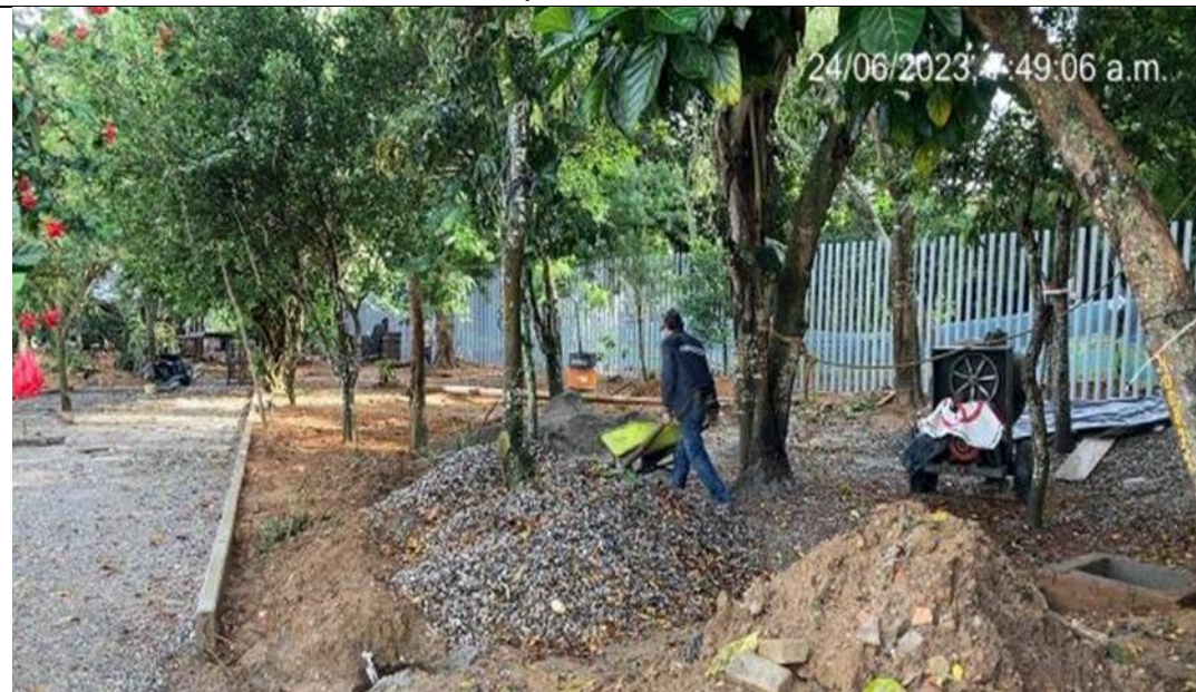
CONSTRUCCION CERRAMIENTO- SENDEROS PEATONALES
