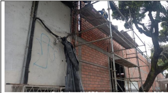
ACTUAL: terminación de muro mampostería 33
