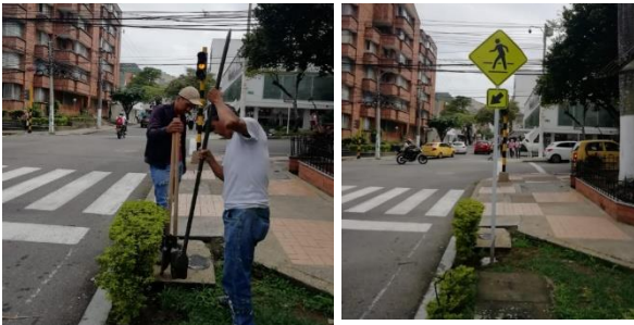
CALLE 52 CON CARRERA 36 INSTALACIÓN DE SEÑAL VERTICAL SP-46B (UBICACIÓN DE CRUCE PEATONAL) CARRERA 22 ENTRE CALLES 51 Y 52 MANTENIMIENTO SEÑALIZACION HORIZONTAL DE RESALTO PARABOLICO
