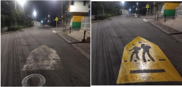
CARRERA 15 ENTRE CALLES 104 Y 104D MANTENIMIENTO DE SEÑALIZACION HORIZONTAL "PICTOGRAMA ZONA ESCOLAR"
