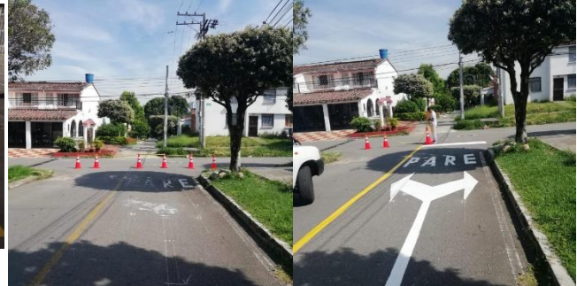
TV 23 CON AV 88 ZONA PEATONAL TIPO CEBRA, LINEA DE PARE, PARE, FL SENCILLA, FLECHA DOBLE, LINEA DE CARRIL BLANCA
