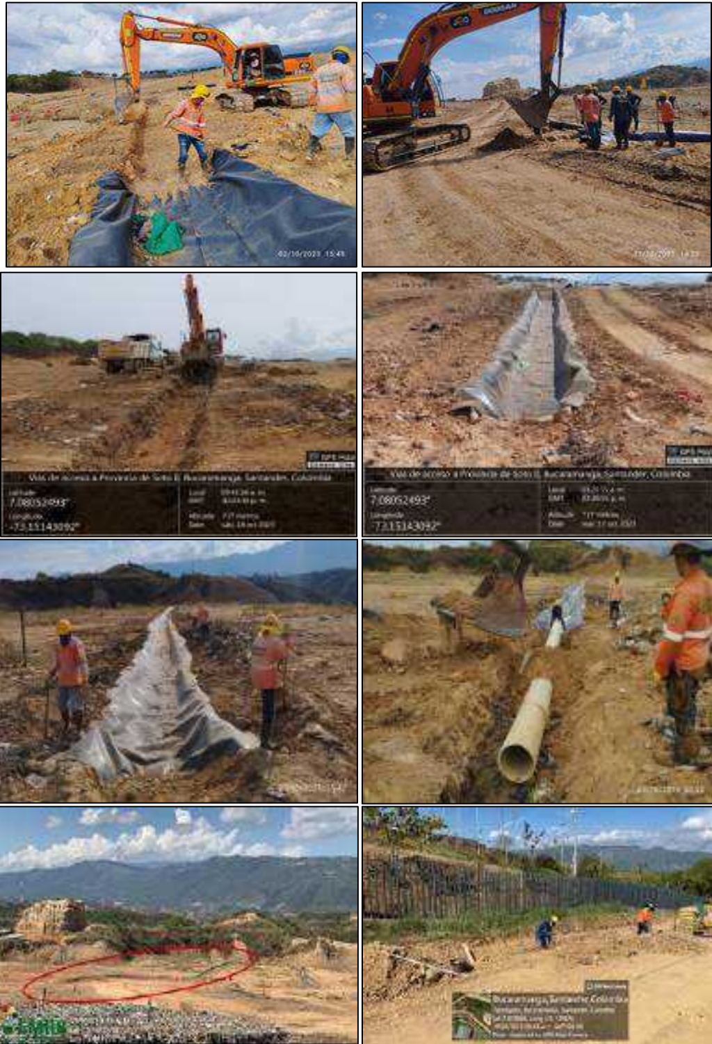
Ilustración 5 Construcción canales para manejo de aguas lluvias y escorrentía, octubre 2023
