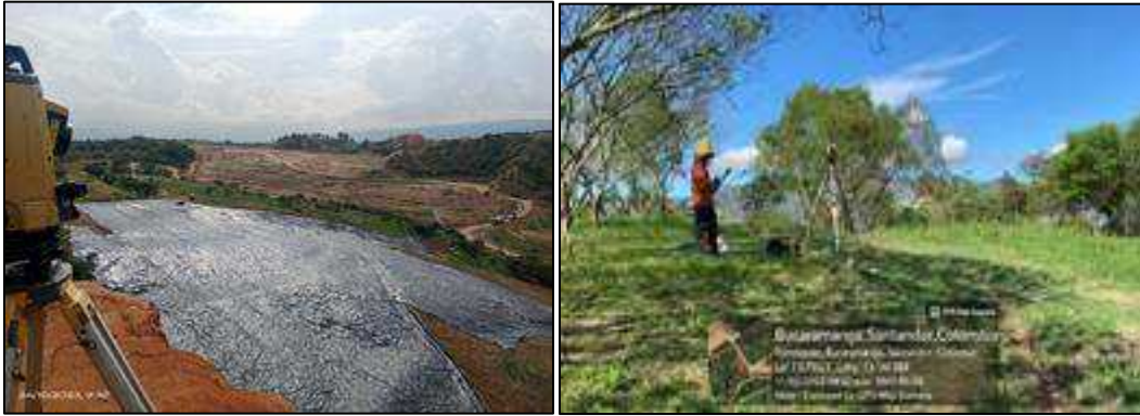
Ilustración 37 Registro fotográfico monitoreo topográfico
