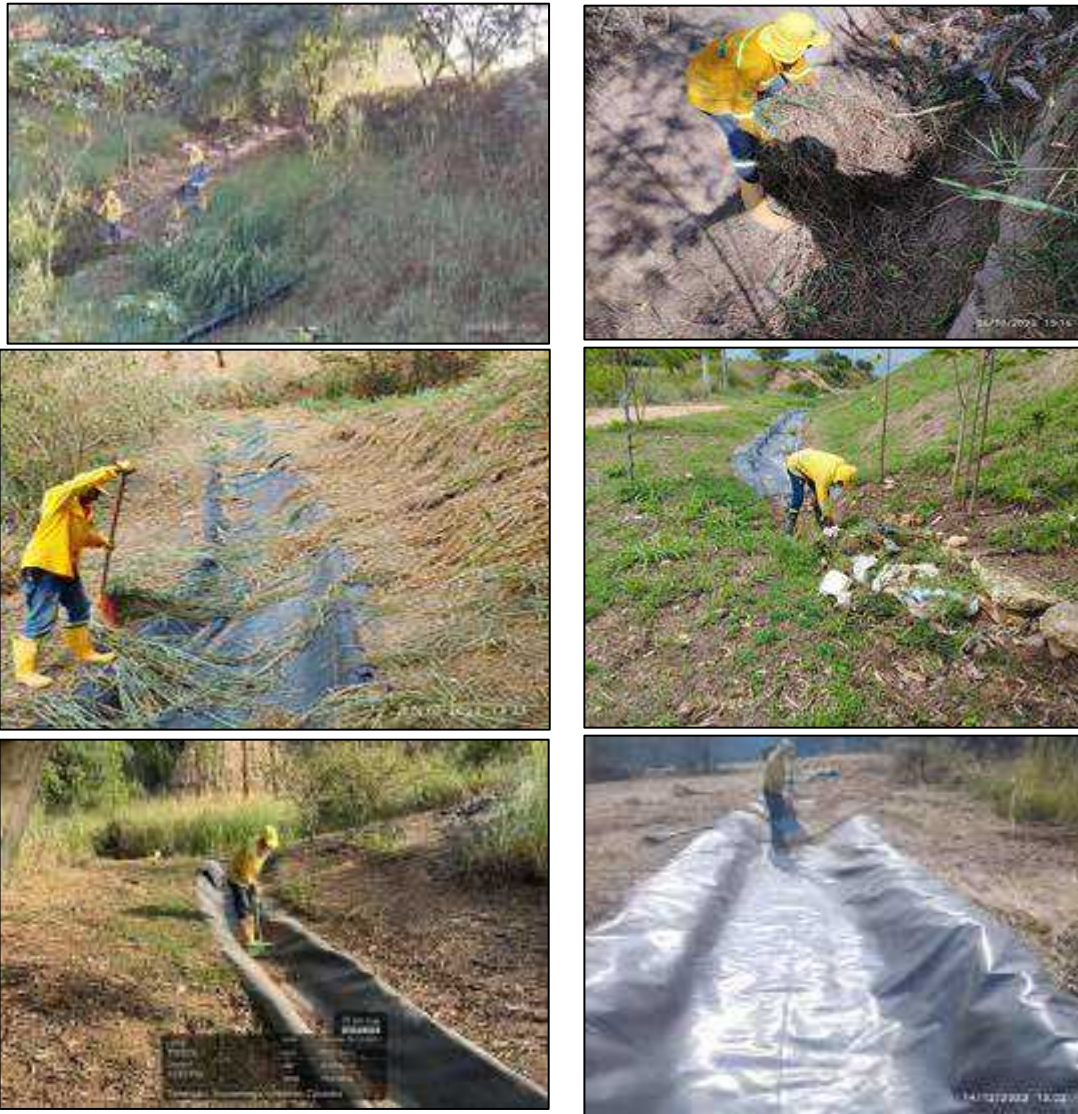
Ilustración 8 Limpieza de los canales de aguas lluvias.
