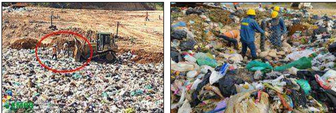
Ilustración 26 Realce de chimeneas celda actual de disposición.
