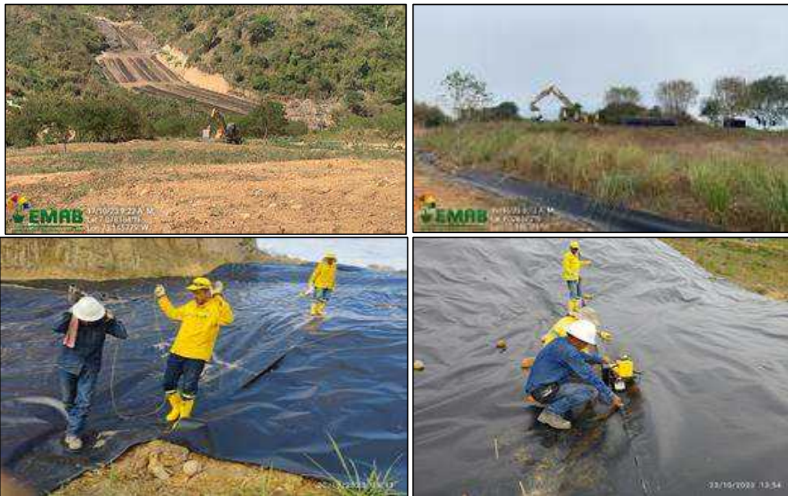
Ilustración 12 Actividades de impermeabilización celda de contingencia y celda 2
