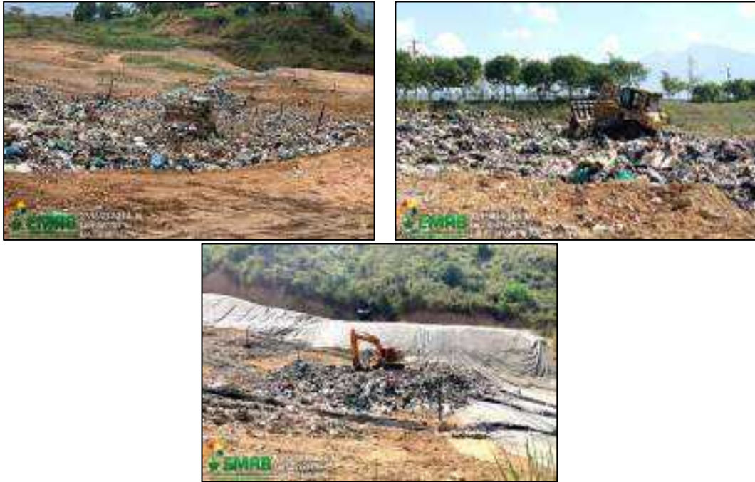
Ilustración 2 Disgregación y compactación de residuos sólidos en la celda actual
