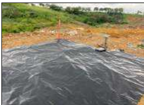
Ilustración 20 Preparación área de caracterización de residuos sólidos
