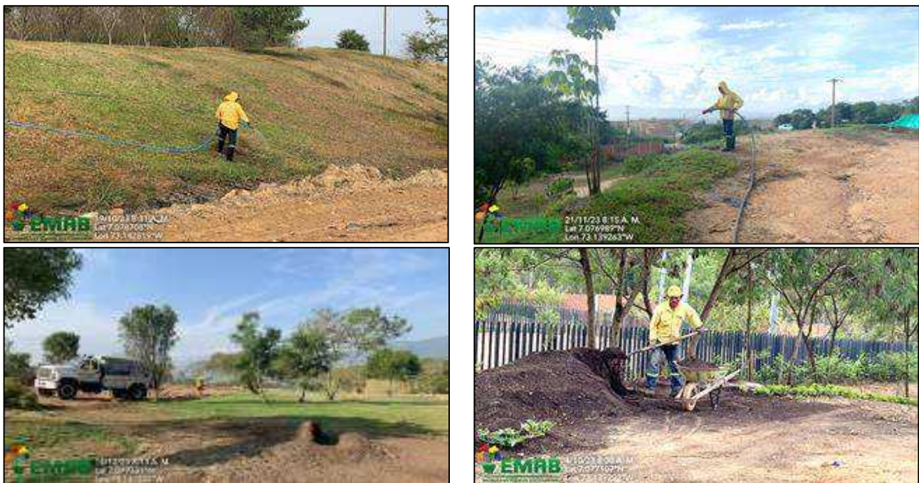
Ilustración 12 Mantenimiento de zonas clausuradas en el sitio de disposición final
