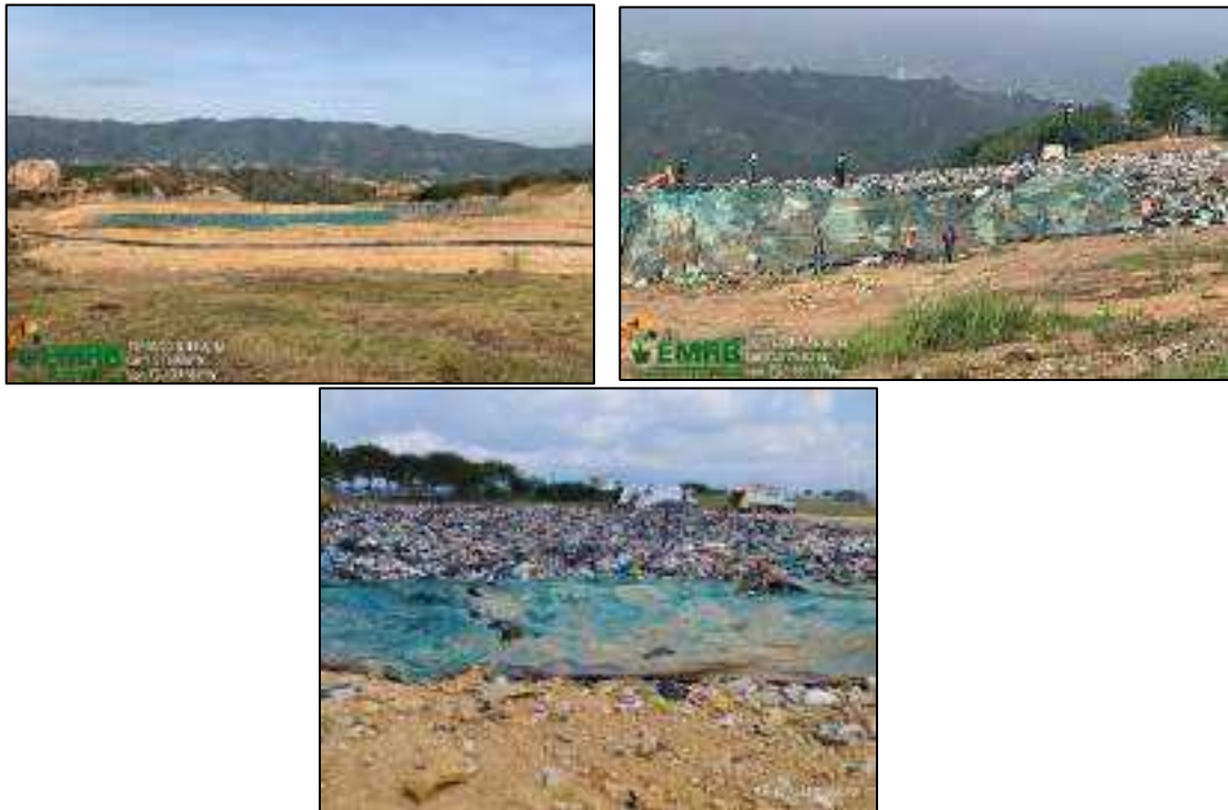
Ilustración 3 Cobertura de residuos sólidos con lona sintética
