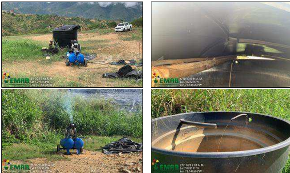
Ilustración 50 Actividades de extracción forzada de lixiviados
