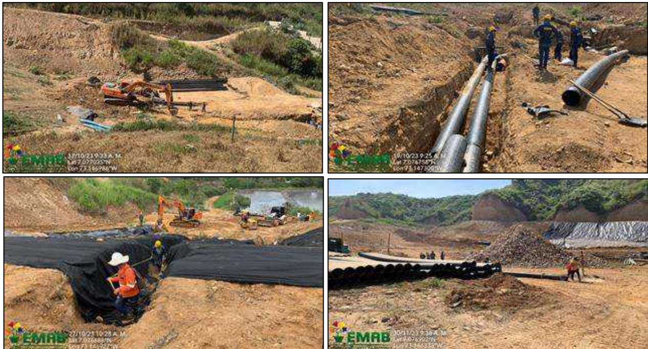
Ilustración 10 Construcción de sub drenes etapa 1 del estudio y diseño de la capacidad remanente 2023
