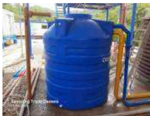
Reemplazo tanque de 2,2 m 3 salida DAF (Enero/23)
