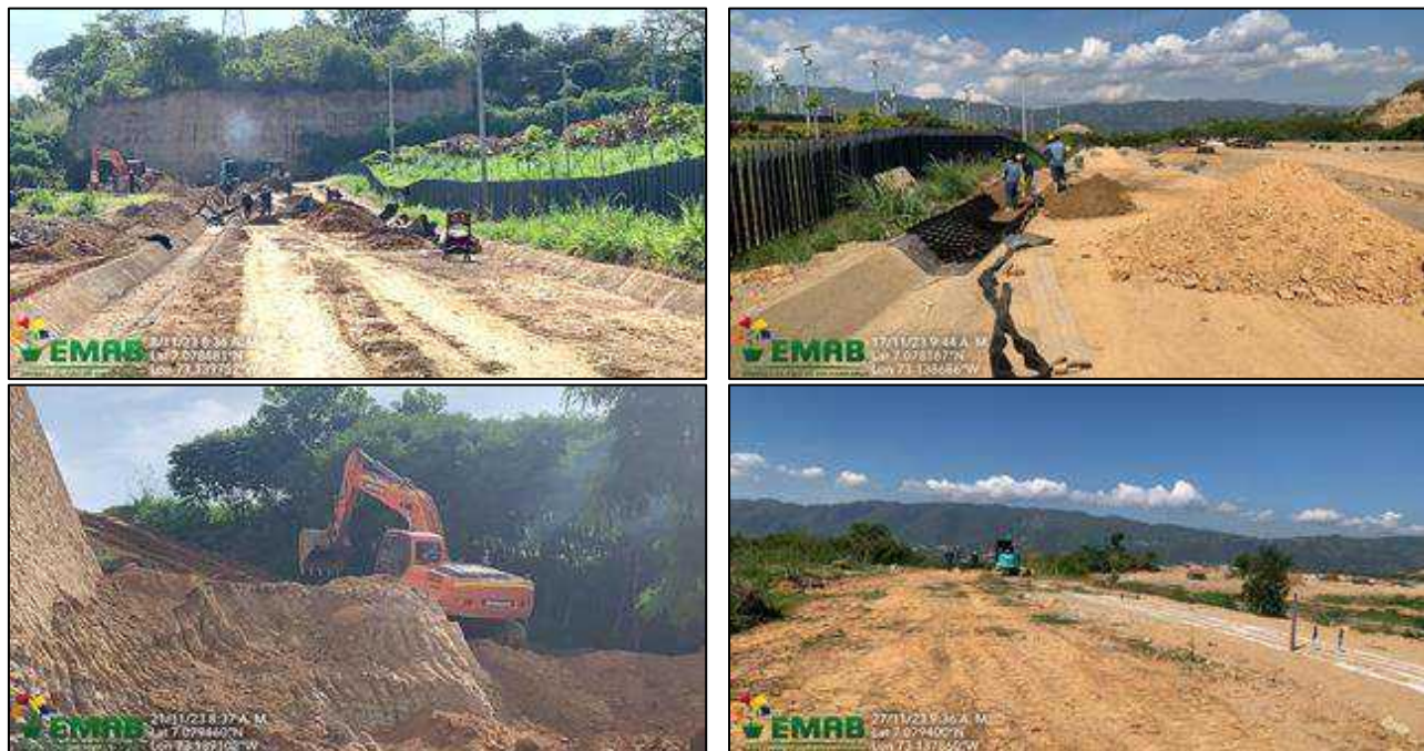
Ilustración 6 Construcción canales para manejo de aguas lluvias y escorrentía, noviembre de 2023
