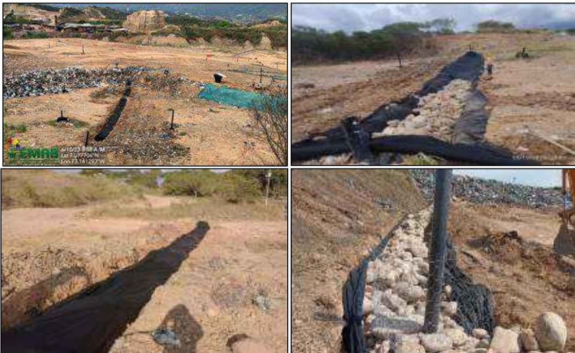
Ilustración 9 Construcción de sistema de drenaje de lixiviados sobre la superficie de la Etapa F
