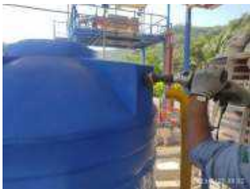
Reemplazo tanque de 2,2 m 3 salida DAF (Enero/23)
