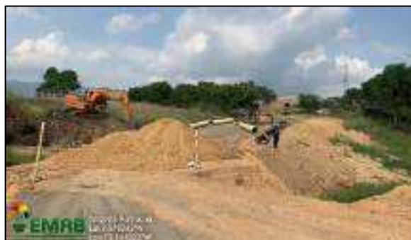
Ilustración 7 Construcción canales para manejo de aguas lluvias y escorrentía, diciembre de 2023
