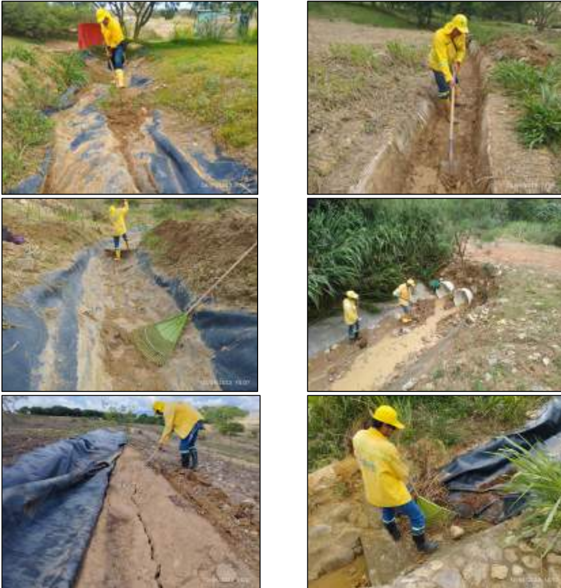
Ilustración 9 Limpieza de los canales de aguas lluvias.
