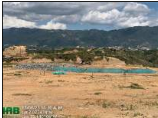
Ilustración 3 Cobertura de residuos sólidos con lona sintética
