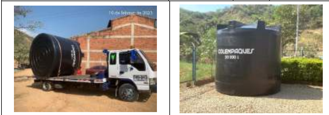
Adecuación e instalación del tanque nuevo de 20 m 3 (Febrero/23)
