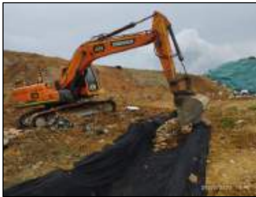
Ilustración 10 Construcción de canales de aguas lluvias
