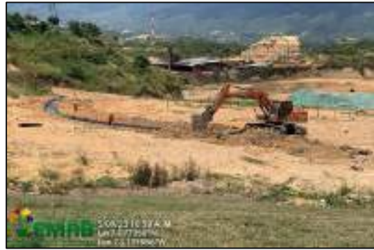
Ilustración 7 Construcción de canales de aguas lluvias
