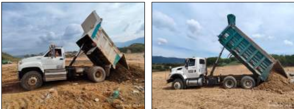
Ilustración 4 Cobertura de residuos sólidos con material terroso o granular
