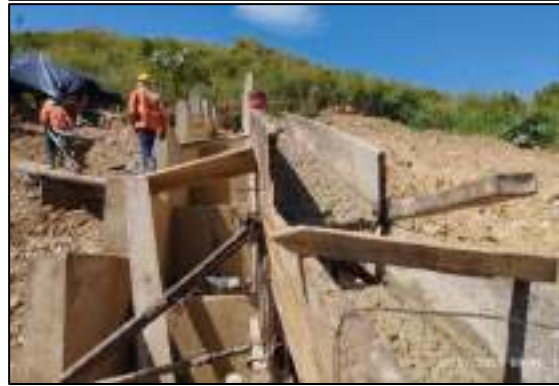
Ilustración 6 Reconstrucción torrentera contigua a las lagunas de homogenización (Pondajes).
