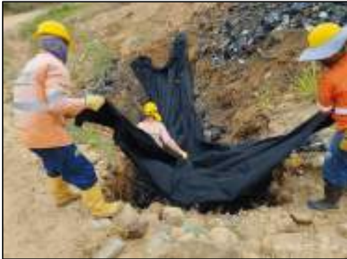
Ilustración 11 Construcción de canales de aguas lluvias
