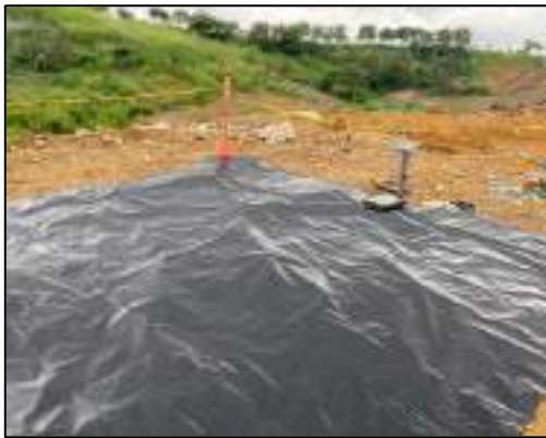
Ilustración 17 Preparación área de caracterización de residuos sólidos
