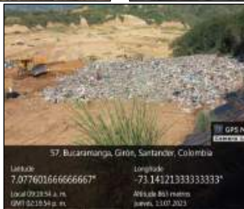
Ilustración 2 Disgregación y compactación de residuos sólidos en la celda actual
