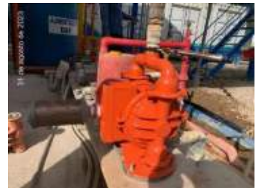
Instalación de una nueva bomba neumática de lodos (Agosto/23)
