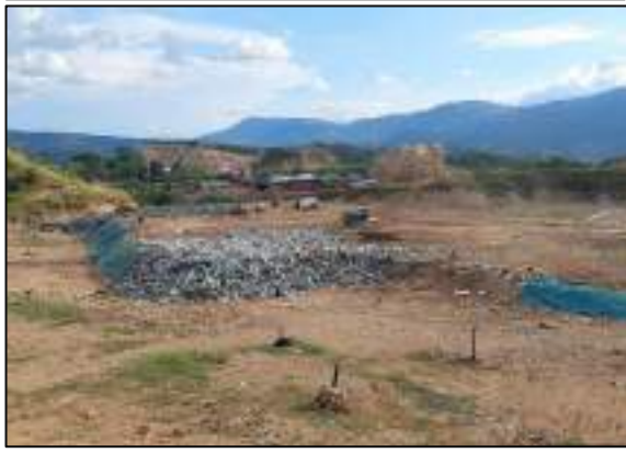
Ilustración 3 Cobertura de residuos sólidos con lona sintética
