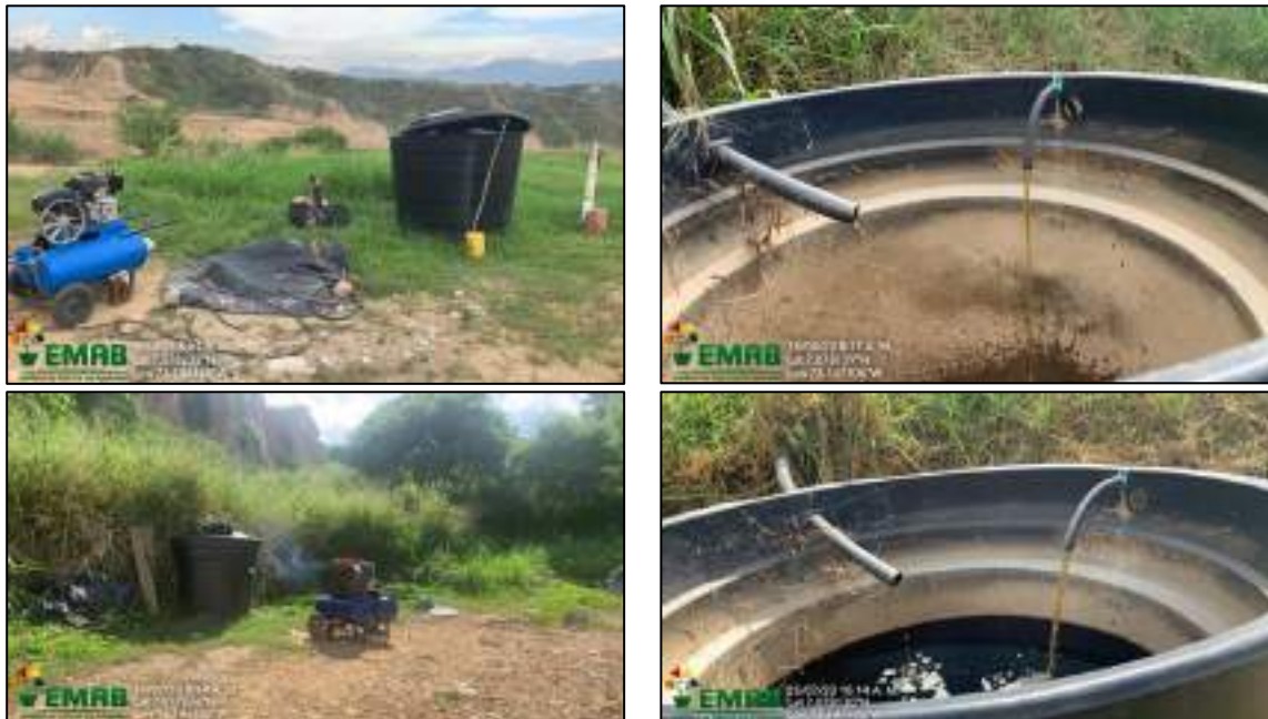
Ilustración 48 Actividades de extracción forzada de lixiviados
