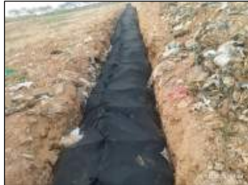
Ilustración 11 Construcción de canales de aguas lluvias
