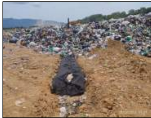
Ilustración 10 Construcción de canales de aguas lluvias
