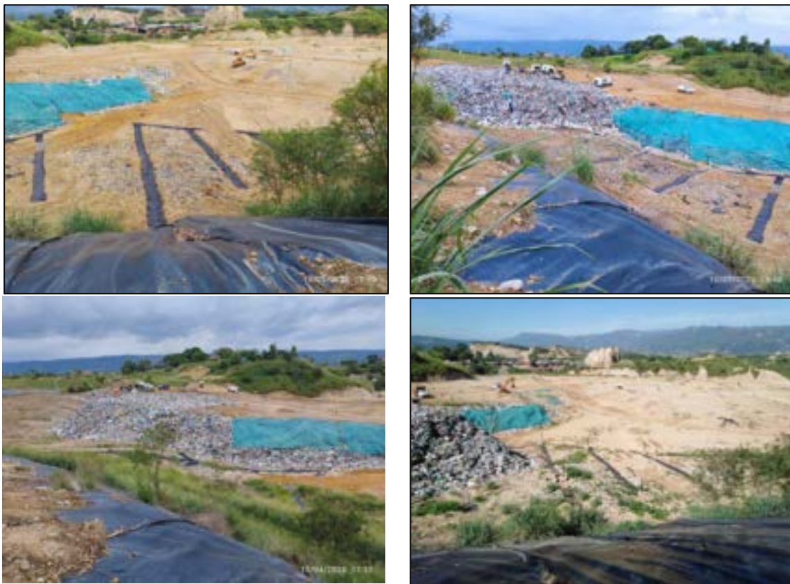
Ilustración 3 Cobertura de residuos sólidos con lona sintética
