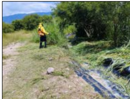
Ilustración 12 Limpieza y deshierbe de canales de aguas lluvias en zonas clausuradas
