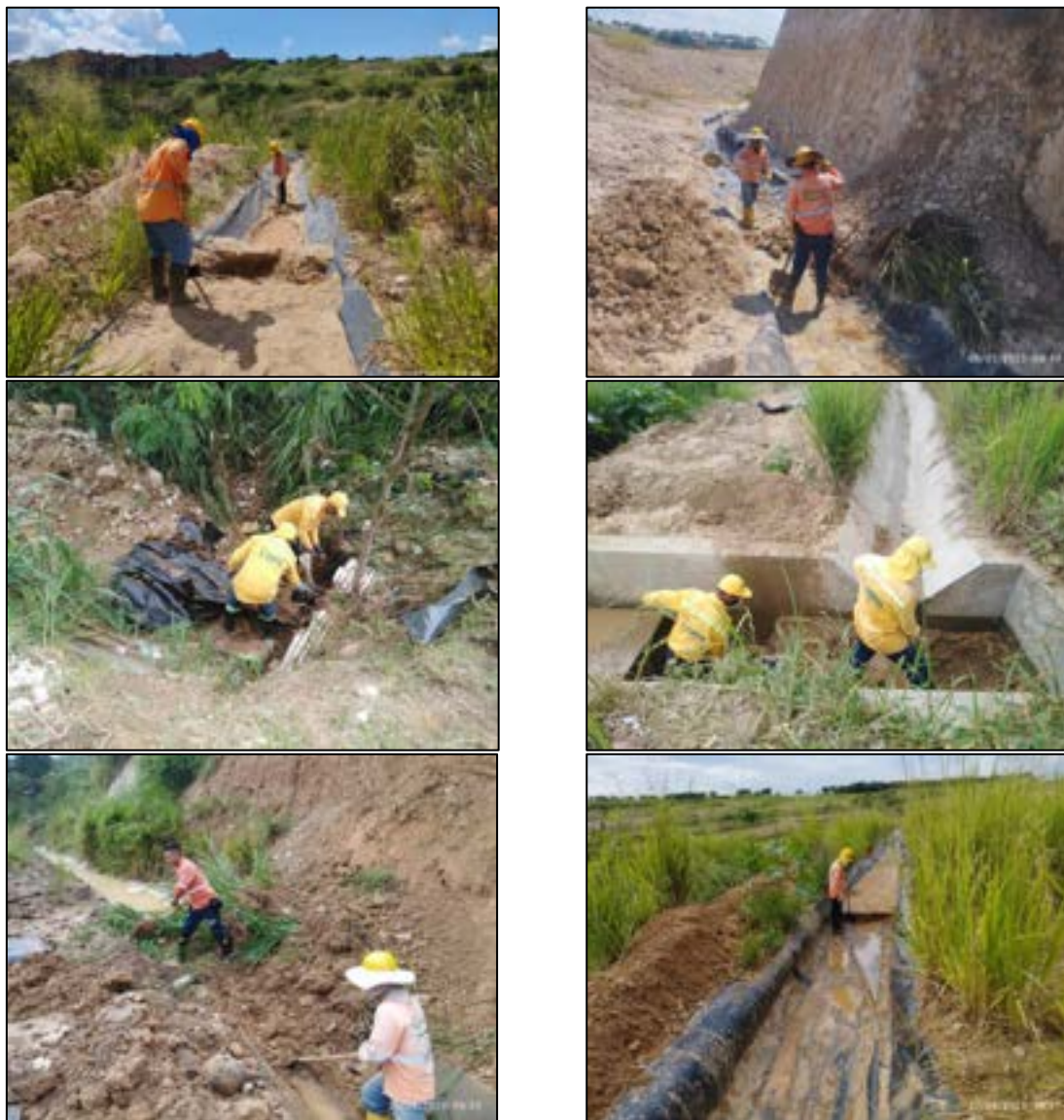
Ilustración 7 Limpieza de los canales de aguas lluvias
