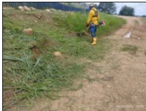
Ilustración 14 Limpieza y deshierbe de canales de aguas lluvias en zonas clausuradas
