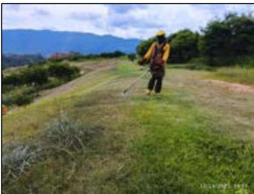
Ilustración 13 Limpieza y deshierbe de canales de aguas lluvias en zonas clausuradas
