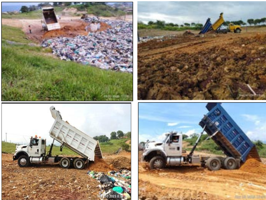
Ilustración 4 Cobertura de residuos sólidos con material terroso o granular
