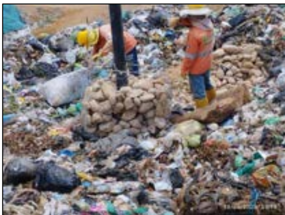
Ilustración 29 Realce de chimeneas celda actual de disposición.
