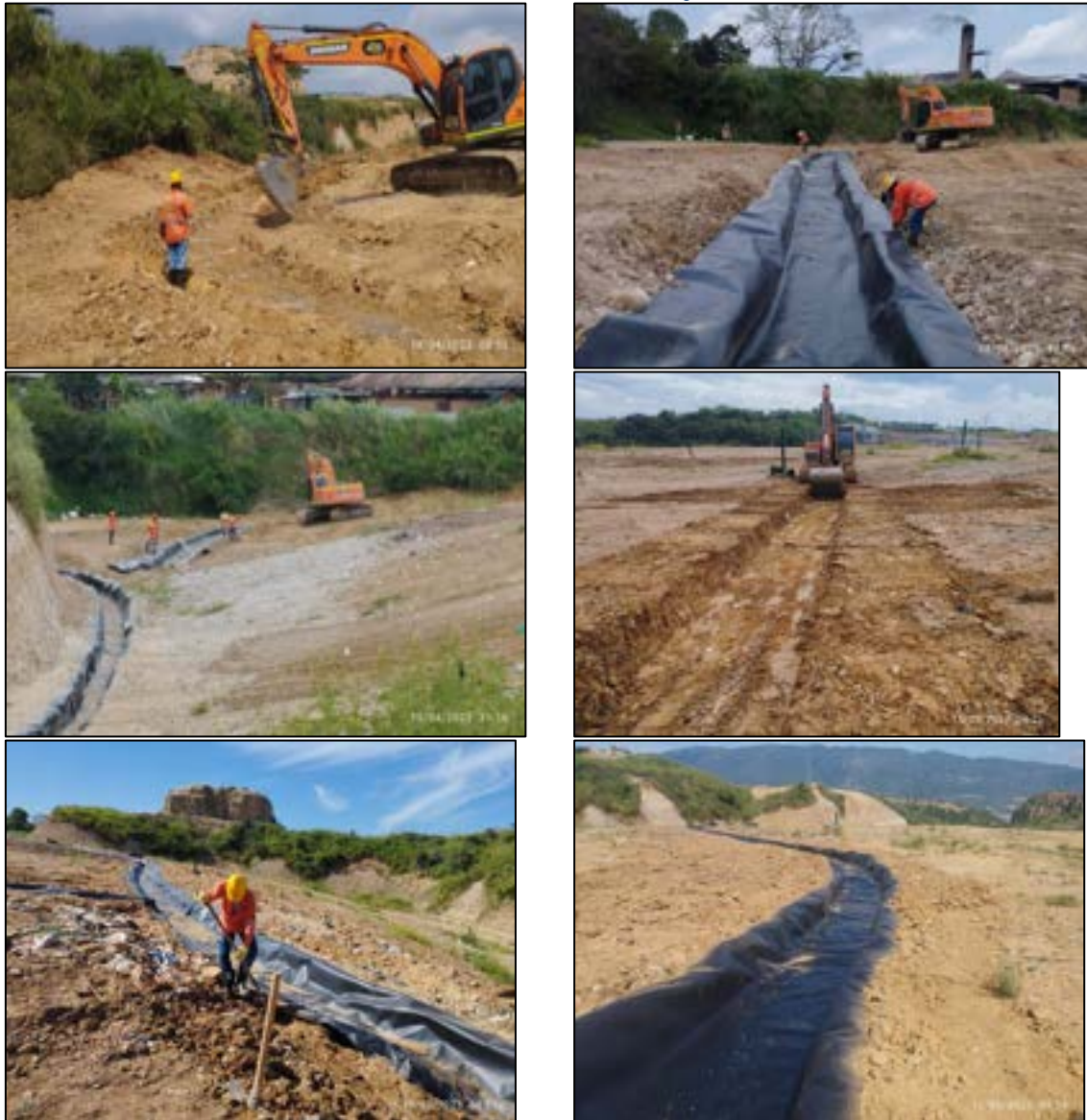
Ilustración 6 Construcción de canales de aguas lluvias
