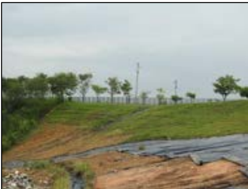
Ilustración 11 Siembra de gramíneas en el talud de la celda 4
