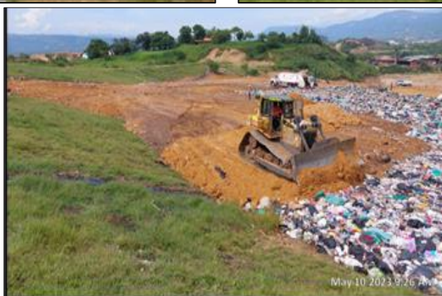
Ilustración 2 Disgregación y compactación de residuos sólidos en la celda actual
