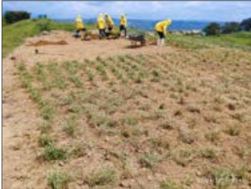
Ilustración 9 Establecimiento de la capa de orgánica en 2700 m2 de geocelda en la celda 4
