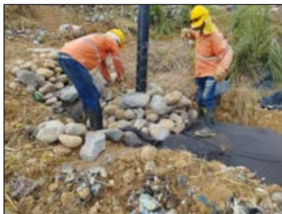
Ilustración 32 Realce de chimeneas celda actual de disposición.
