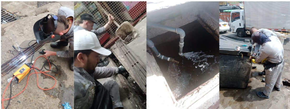
SAN FRANCISCO: soldadura y cambio de rejillas de alcantarillado, mantenimiento de bombas del tanque aéreo, mantenimiento de góndolas de aseo.
