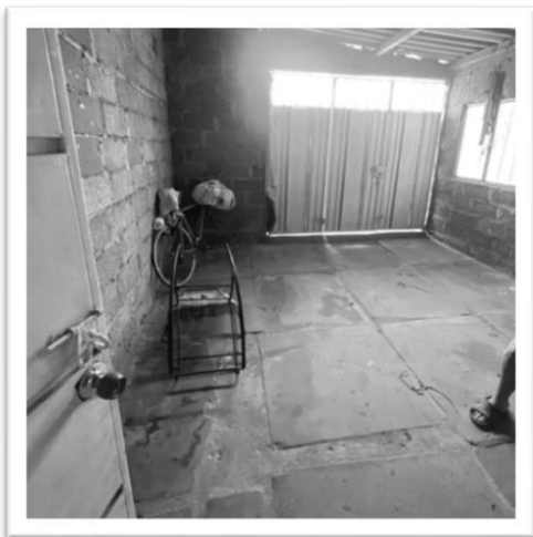
Estado inicial de la vivienda previo a las obras de mejoramiento
