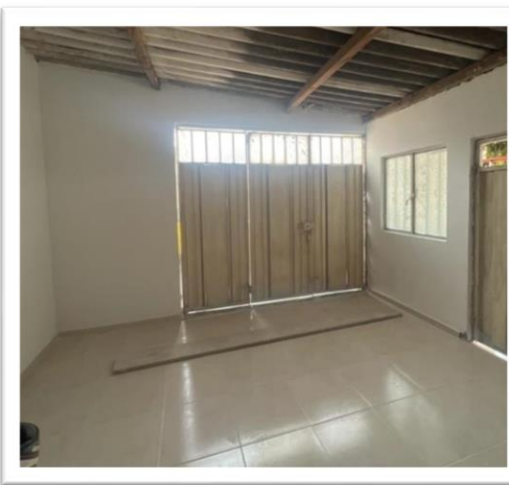
Estado de la vivienda posterior a las obras de mejoramiento.
