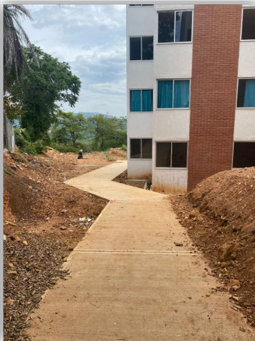
Fotografía 1. Andén de acceso a la torre 7
