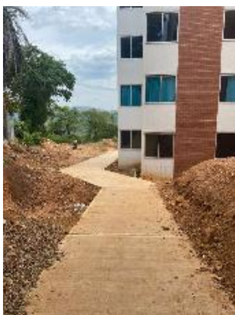
Fotografía 1. Andén de acceso a la torre 7
