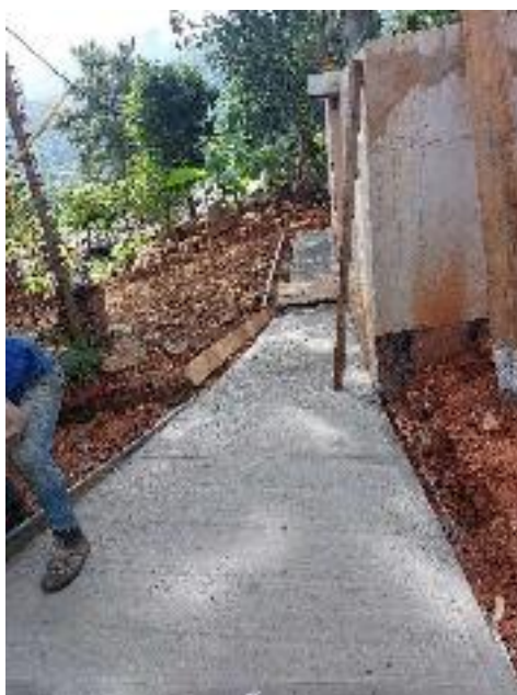
Fotografía 6. Andén de acceso al tanque de almacenamiento de agua
