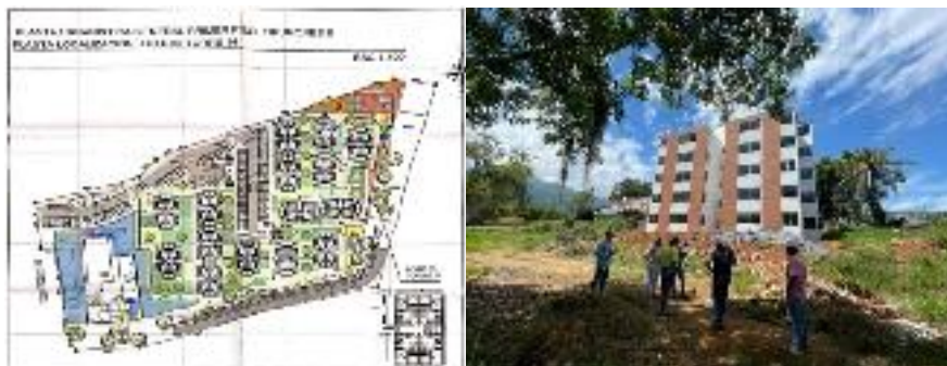
Ilustración 2. Torre 14 - NCT II
