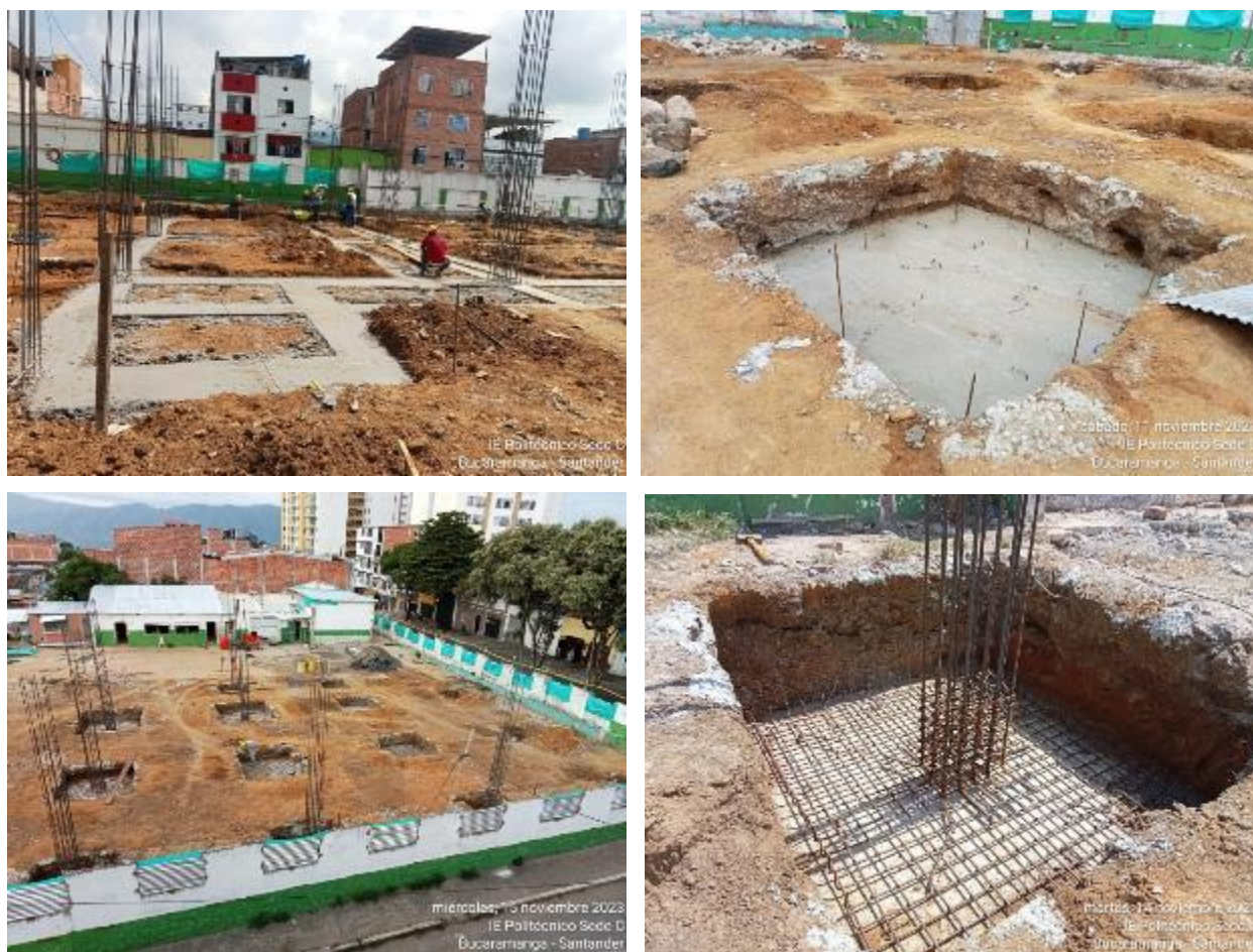
Fotografías de avance de la obra Politécnico sede C, Fuente. Oficina Bienes y Servicios SEB
