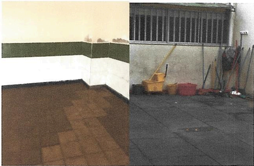
Condiciones de aseo Instalaciones primera planta
