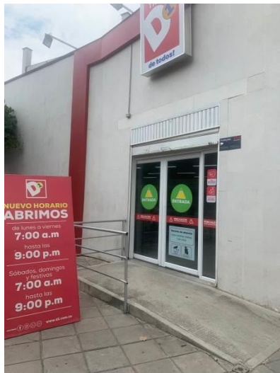
RAMPA DE ACCESO-TIENDA D1-DIAMANTE 2
