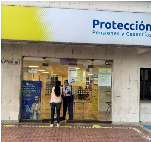
Entrada a la Oficina, puerta amplia y rampa de acceso
